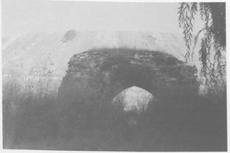
Res.8: Dört ayaklı yapının yakından görünüşü.
