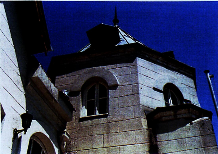
Foto 3: Konya, Sanayi Mektebi'nin güneye bakan ön cephesinden ayrıntı.(1996)
