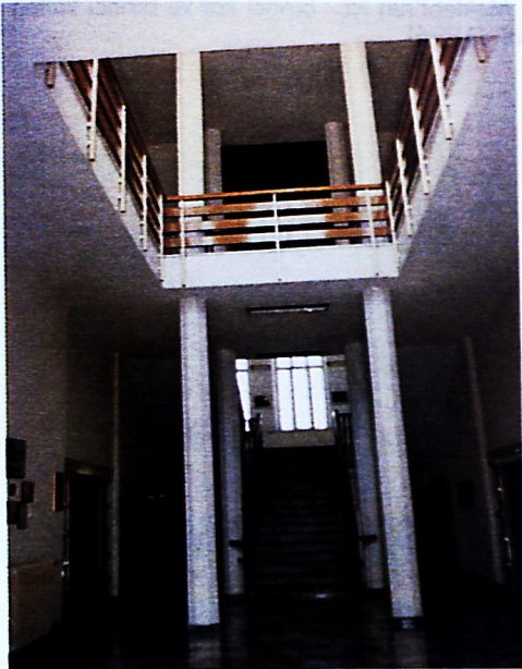
Foto 12: Konya, Sanayi Mektebi'nin içi; zemin kat ile, buradan birinci kata bakış ve merdivenler. (1996)
