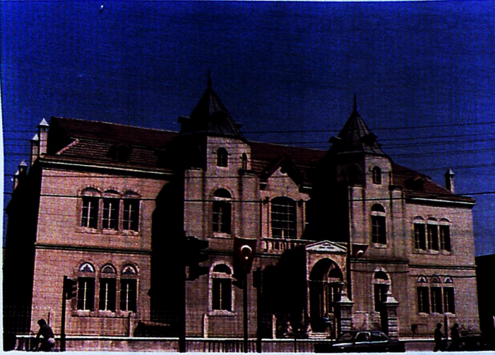
Foto 1: Konya, Sanayi Mektebi'nin güneye bakan ön cephesinden genel görünüş.(1996)
