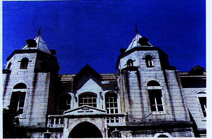
Foto 2: Konya, Sanayi Mektebi'nin güneye bakan ön cephesinden ayrıntı. (1996)
