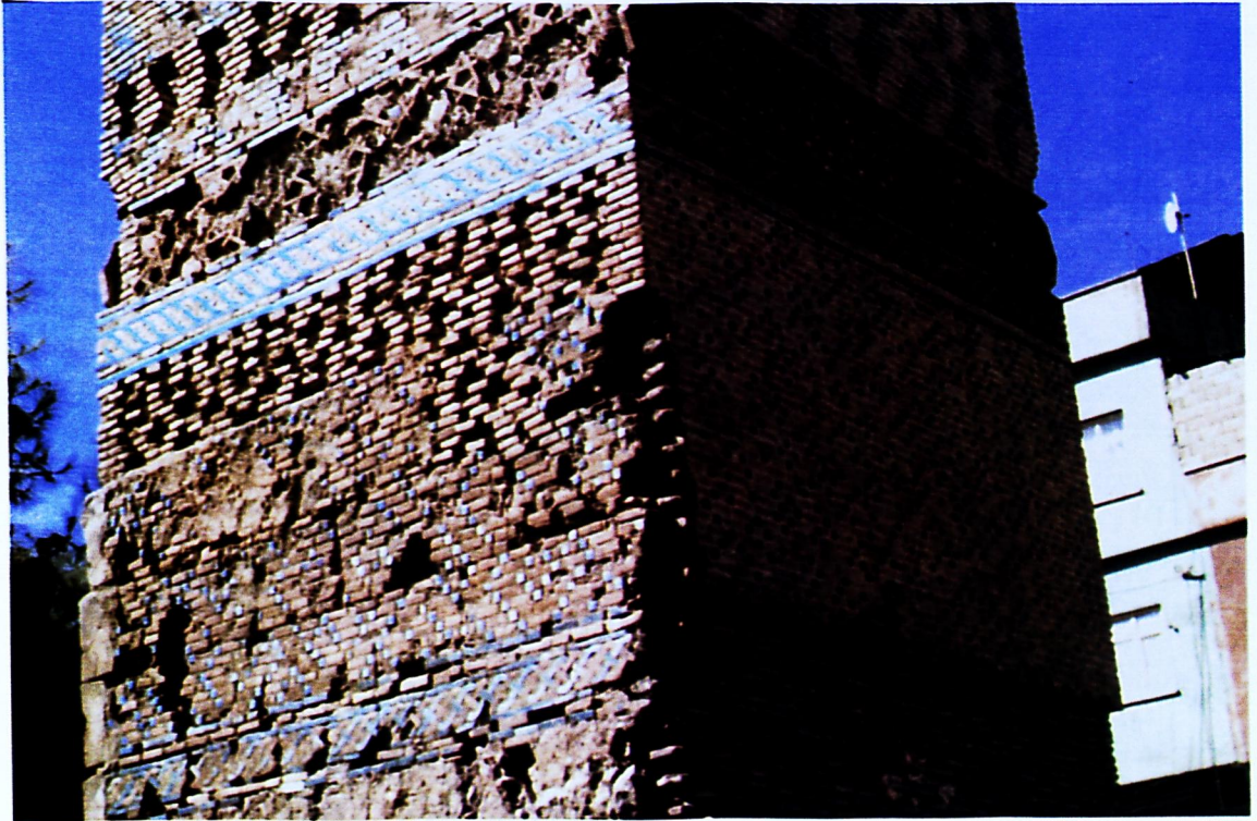
Fot.6 Siirt Ulu Cami Minaresi, Kaide Güneydoğu Cephe, II. Bölüm.
