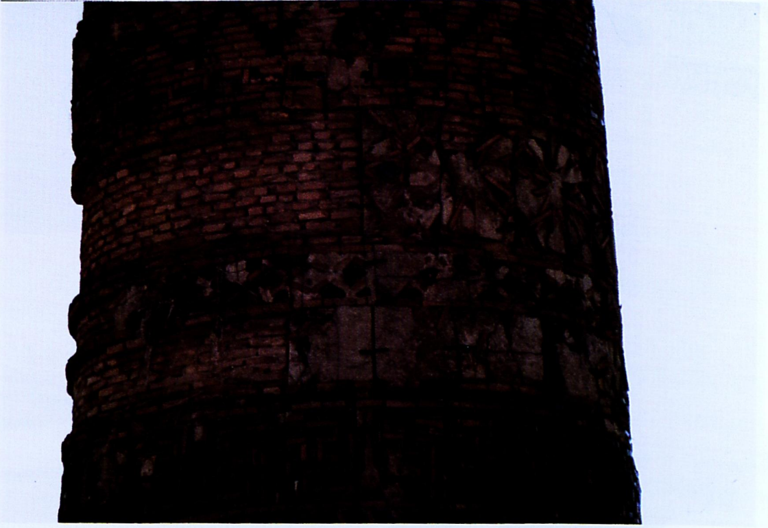
Fot.11 Siirt Ulu Cami Minaresi, Gövde Orta Bölümler, Kuzeydoğu Cephe.
