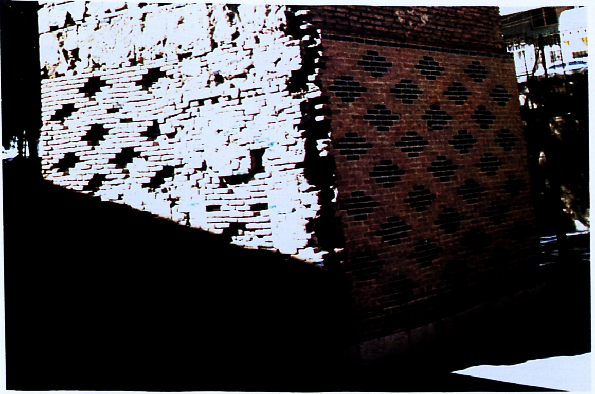
Fot.5 Siirt Ulu Cami Minaresi, Kaide Güneydoğu Cephe, I. Bölüm.
