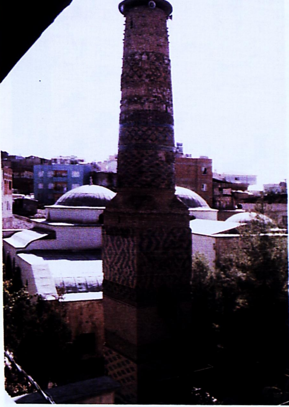
Fot.1 Siirt Ulu Cami Kuzeydoğudan Genel Görünüm.
