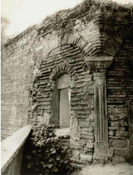
Resim 3.1970 onarım evveli apsis aşından görünüm
