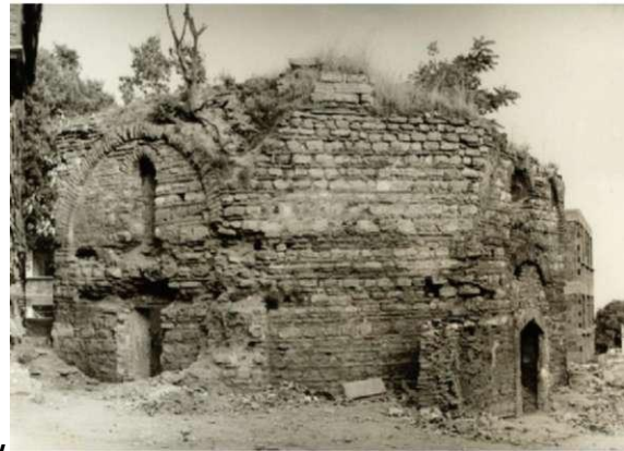
Resim 11. 1970'lerdeki onarım evveli ve sonrasına ait kuzeybatıdan çekilmiş fotoğraflar (Vİ.İ.B.M.A.)
