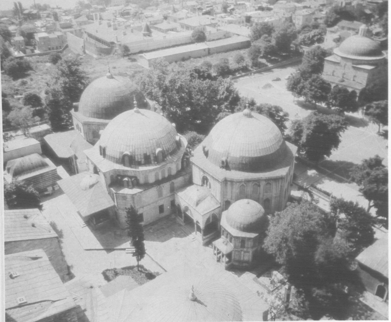
13. Ayasofya Türbeleri (minareden)
