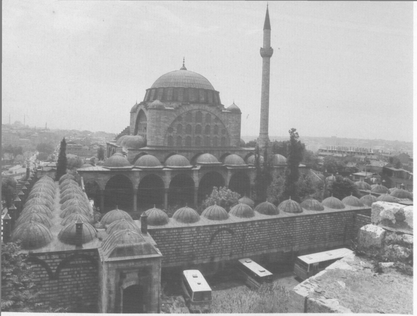
3- İstanbul, Edirnekapı, Mihrimah Camii ve külliyesi (S.Bayram)
