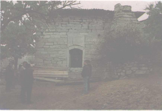
Resim 21: Eldivan, Gölez Köyü Eski Câmii'nin giriş cephesi.
