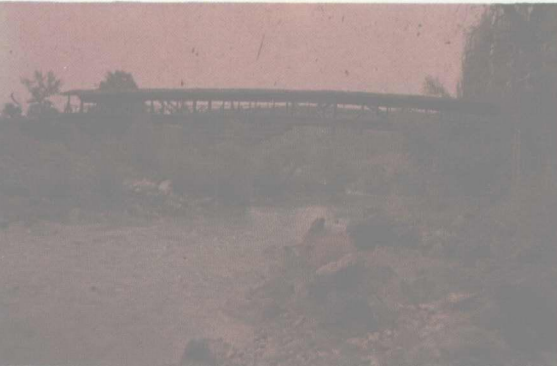
Resim10:Bayramören Köprüsü'nün batıdan görünüşü.
