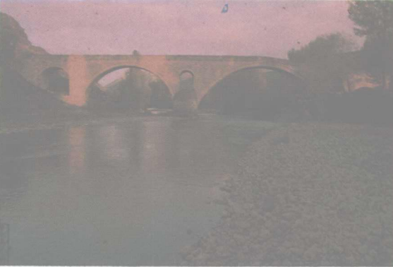
Resim 8: Çerkeş, Akbaş Köyü Köprüsü'nün batı cep- heden görünüşü.
