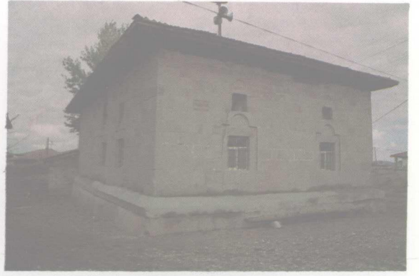
Resim18: Kızılırmak Merkez Camii'nin güney ve batı cephelerinin görünüşü.
