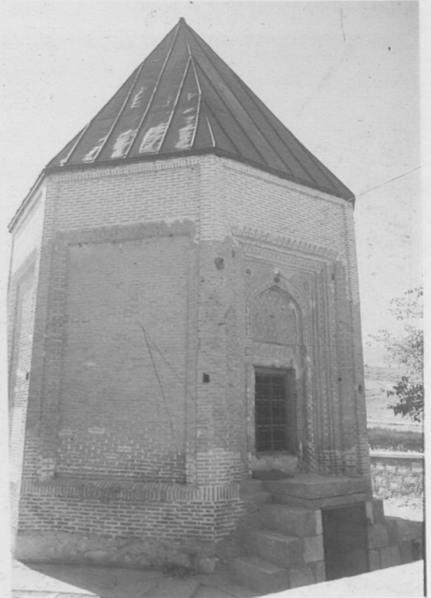
20. Kemah, Mengücek Gazi Türbesi, kuzey- doğudan görünüş (1989)
