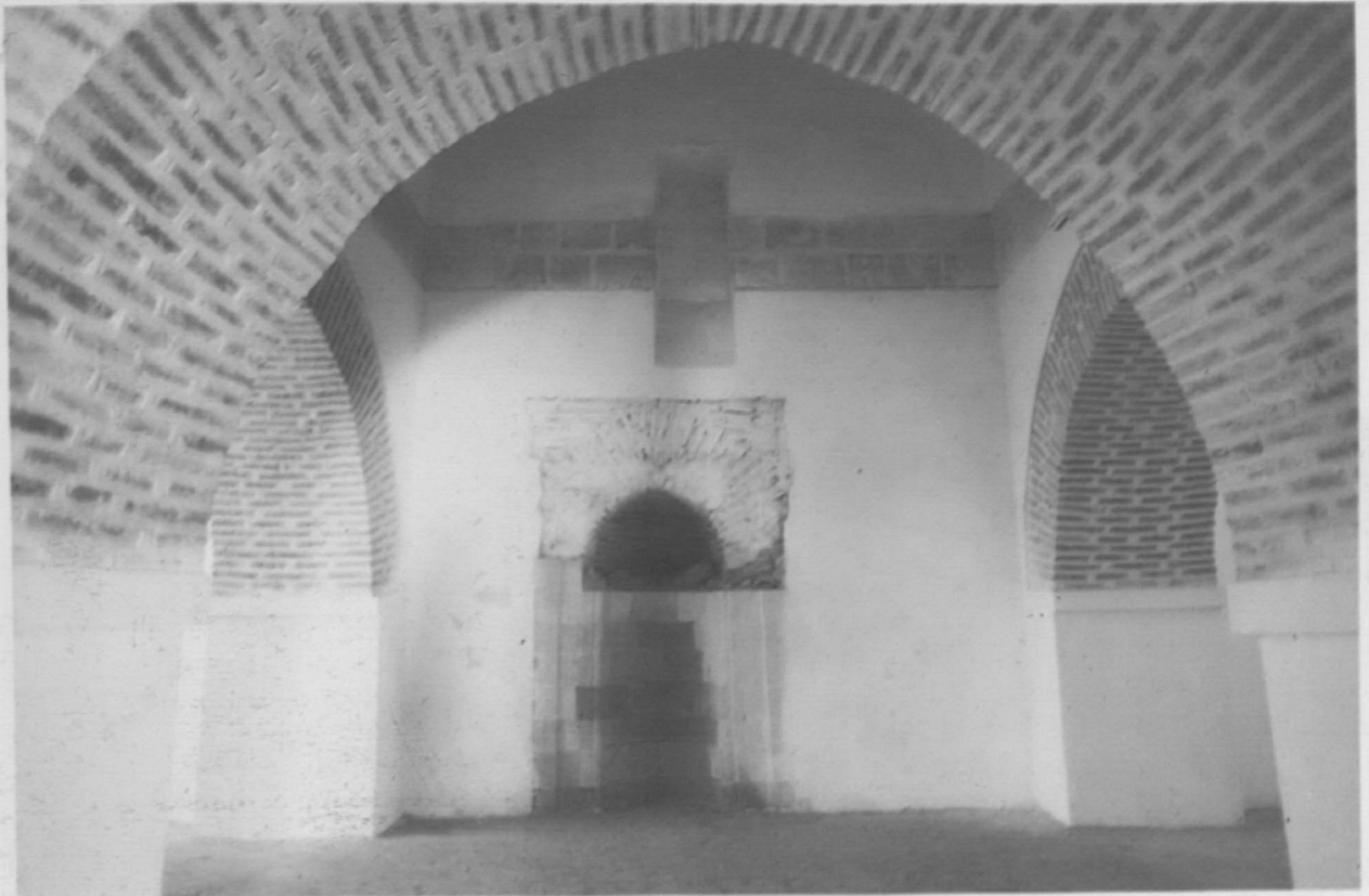
8. Harput Ulu Camii, harim, güney duvar, eksenin batısı (1989)
