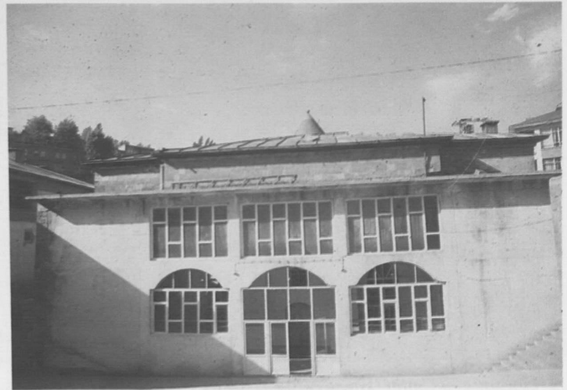
4. Bitlis Ulu Camii, kuzey cephe (1984)
