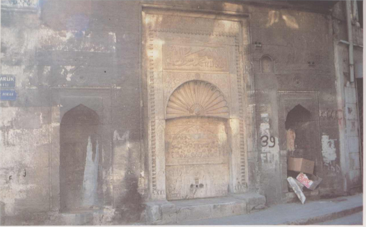
Res. 9: Kemankeş Çeşmesi-Galata 1732-(Restorasyon geçirmiş)
