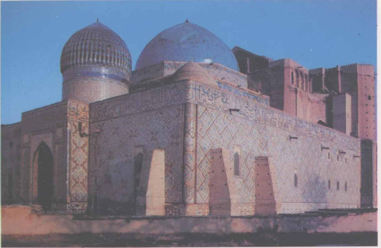
Res. 3: Dış cephe kible tarafı köşe görünüşü.
