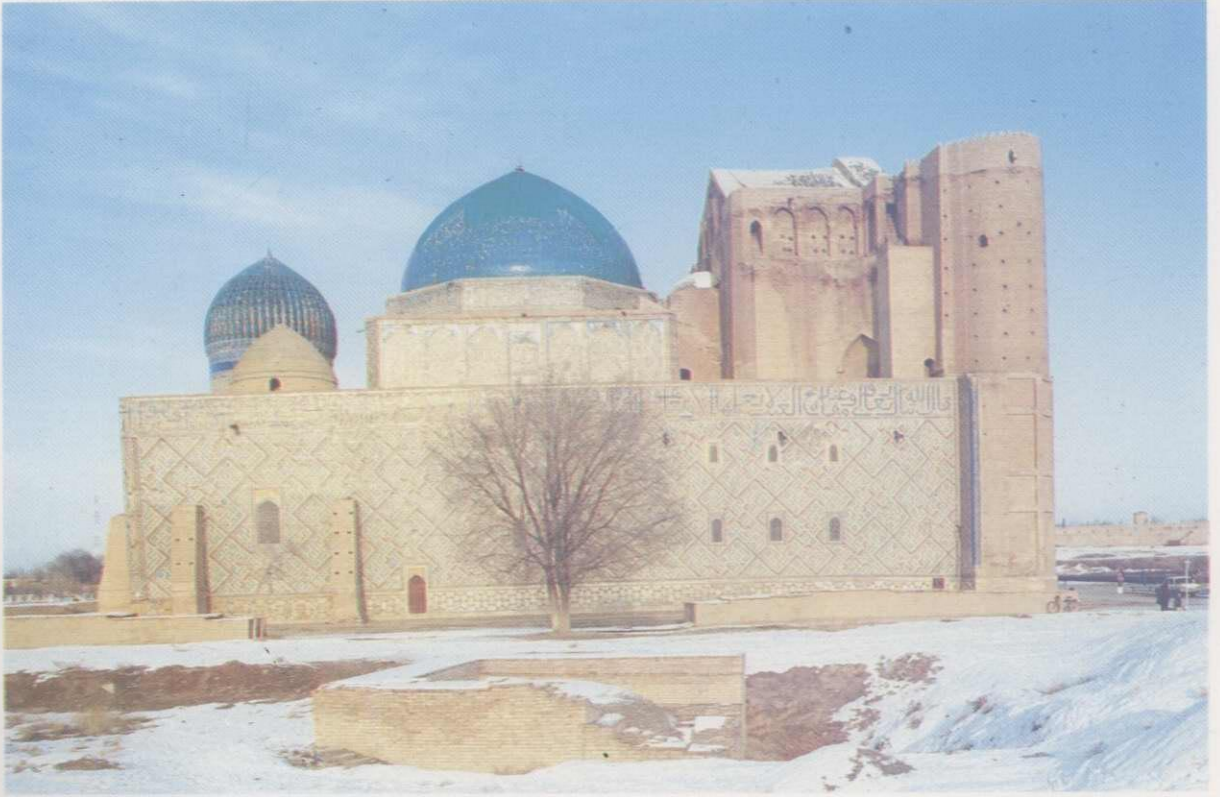
Res. 4: Dış kible cephesi.
