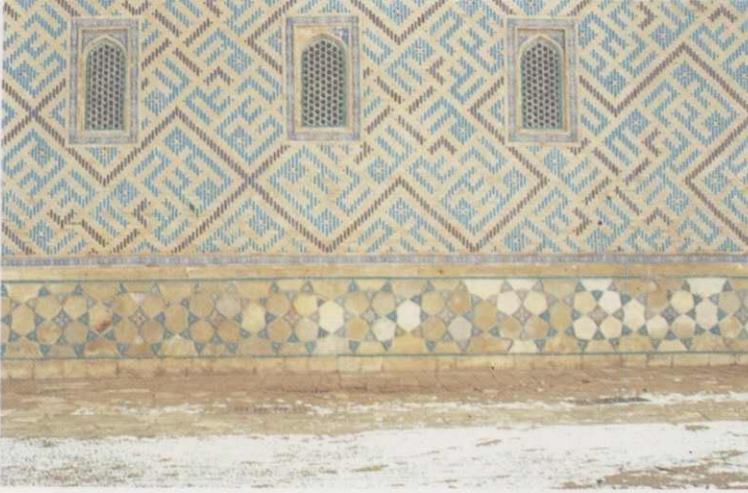
Res. 12: Yan cephe sırlı tuğla kaplama detayları.
