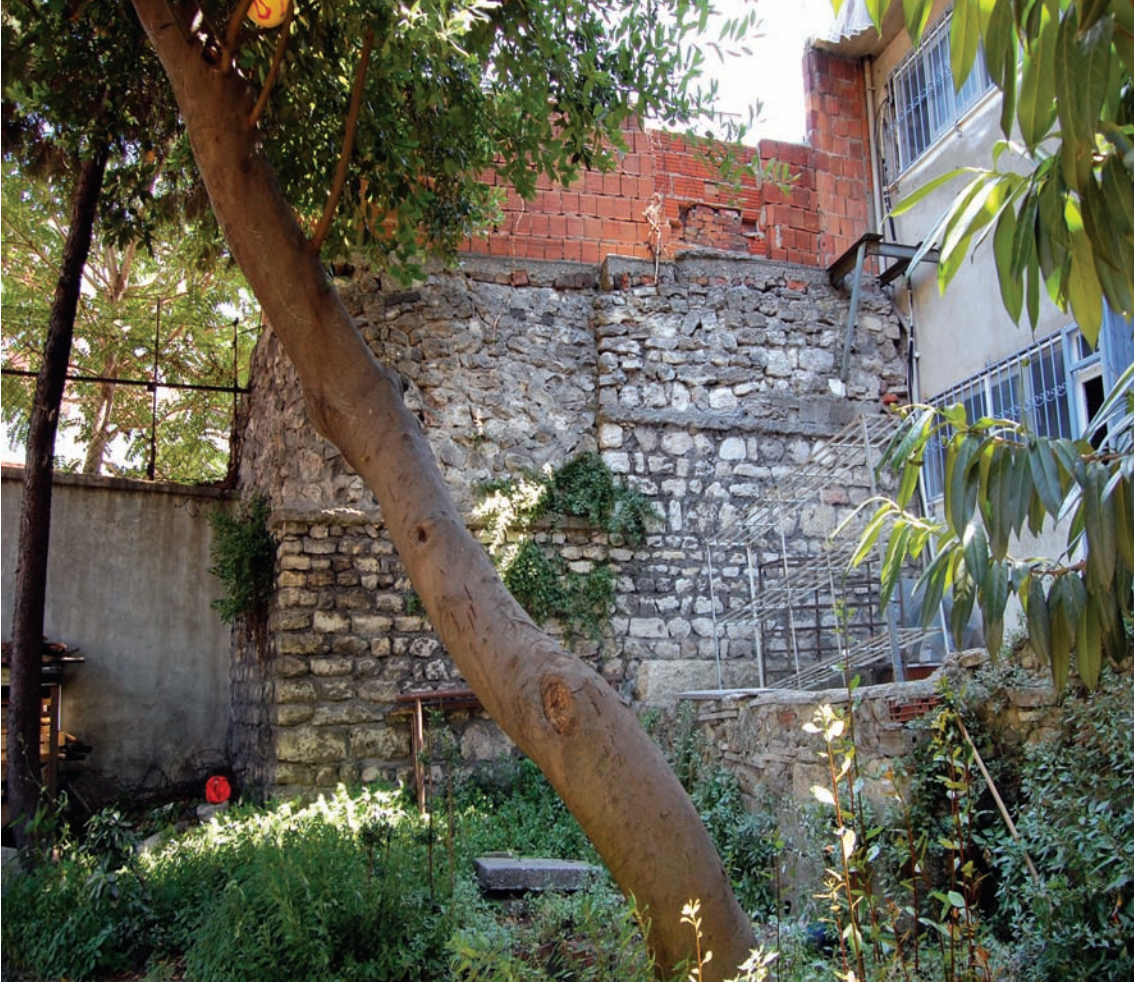
Resim 3. Sarnıcın, mescid avlusunun güneybatısına denk gelen duvarı (M.Sav, 28.06.2012)
