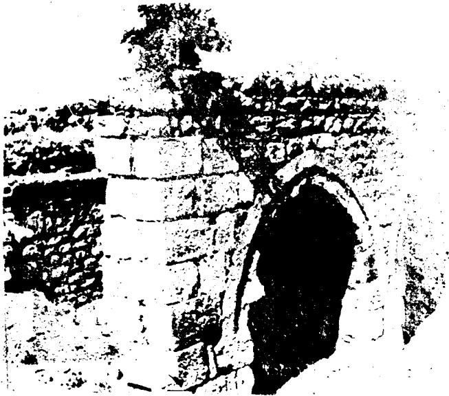
Resim : 15 — 8 No. lu mekanın avludaki görünüşü
