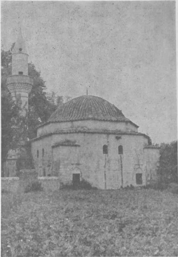
Resim : 2 Antalya Kaş Kasaba Köyü Camii, dış güney görünüşü
