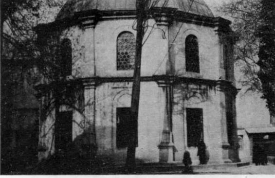
Resim: 27 Fatih Mehmed II Türbesi iç ve dış görünüşü.
