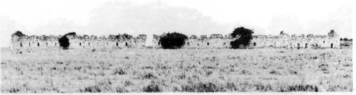
RESİM: 1 Kervansarayın güneyden görünüşü.
