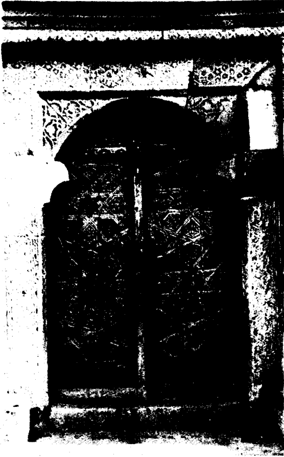
FOTO:22 Sungurbey Camii ve Türbesi, kuzey cephe giriş kapısının 1984 yılındaki durumu. Burada kapı kanatlarındaki bozulmalar açıkça belli olmaktadır.
