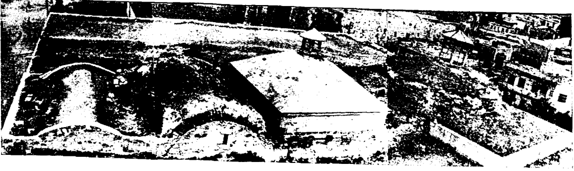
Res. 15 . Erzurum Ulu Camii örtü sirteminin dıştan görünüşü.
