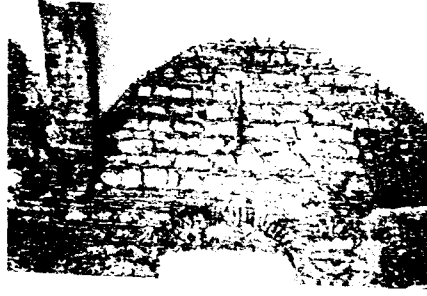
Res. 26 — Medrese hücreleri önündeki revakların sıvanmadan önceki durumu (Fot. Y. Önge)
