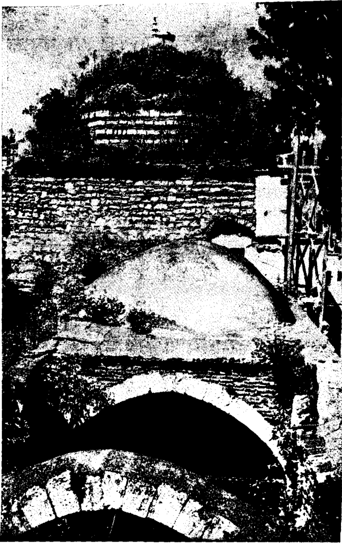
Res. 25 --- Onarım öncesi kütüphane ile medrese hiçerel-rinin bir kısmı
