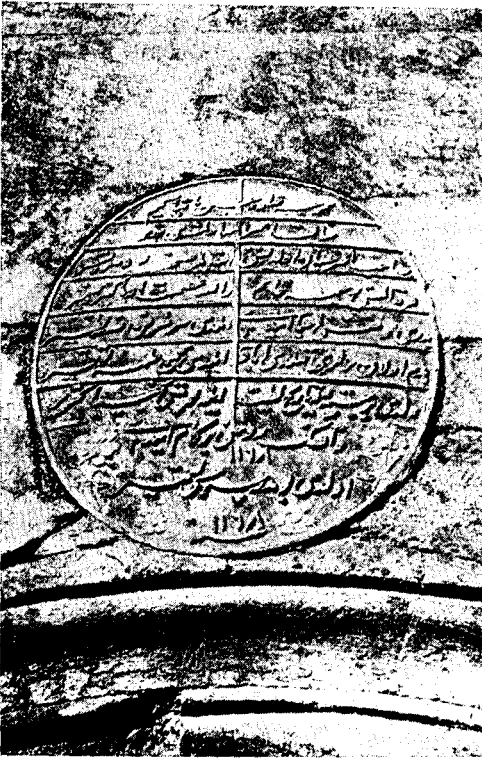
Res. 17 — Kütüphane giriş kapısı üzerindeki tamir kitabesi
