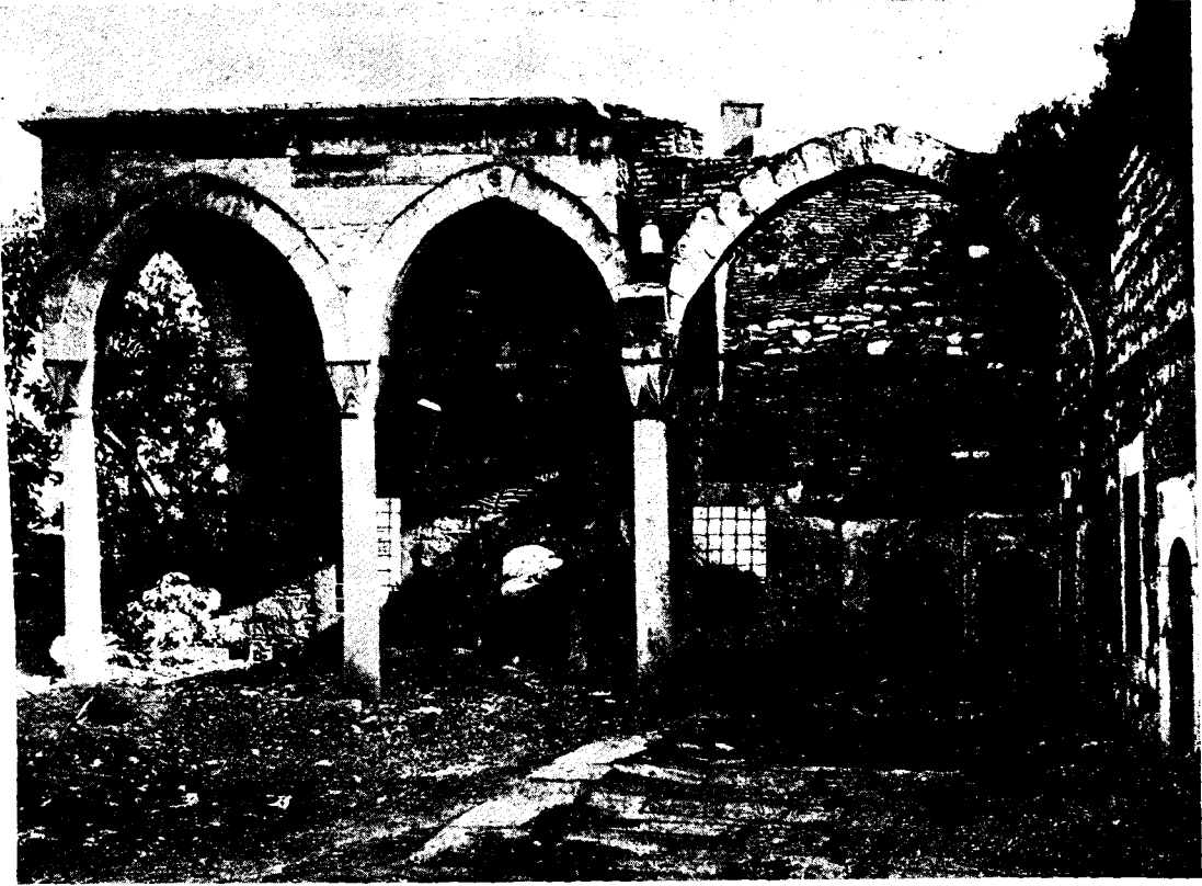
Res. 28 — Onarım öncesi medrese hücrelerinden dershane - mescit tarafındaki bölüm (Fot. H. Doğanbey)
