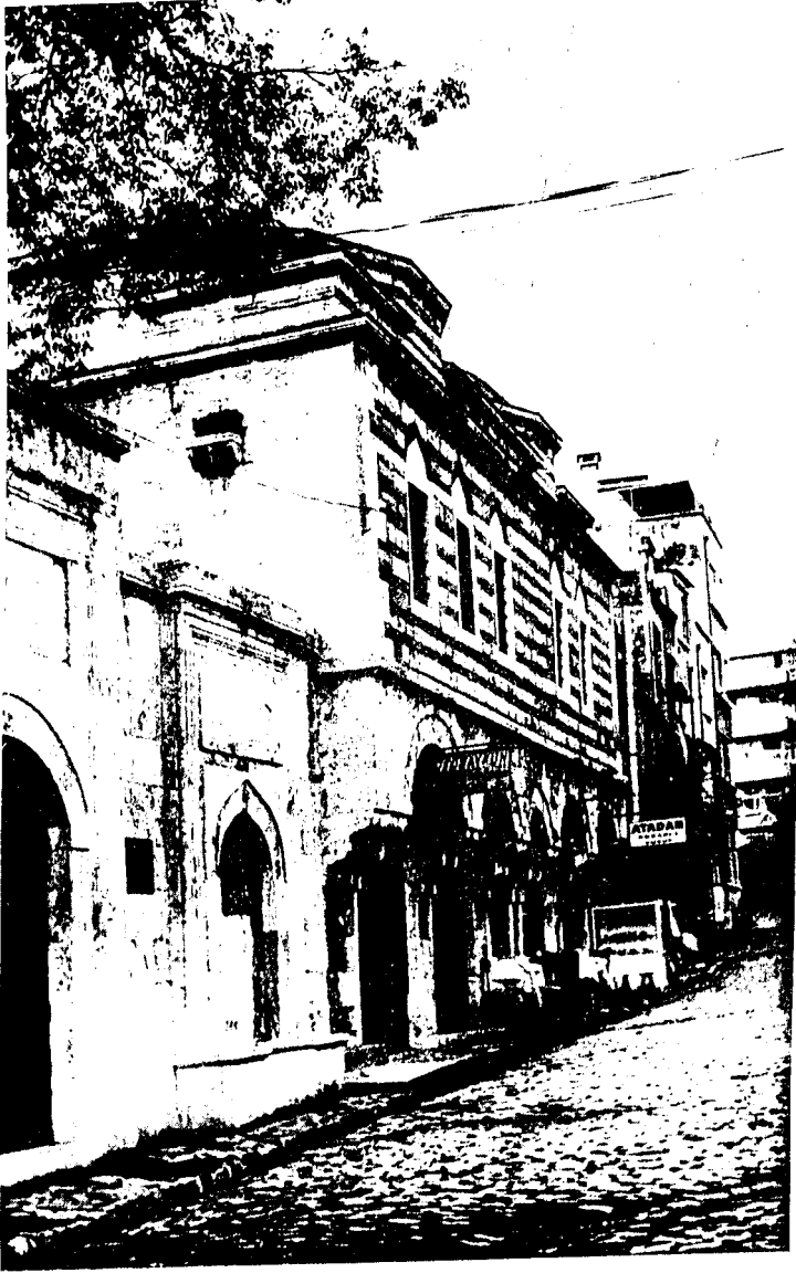
Res. 18 - - Onarım sırasında Sıbyân mektehi
