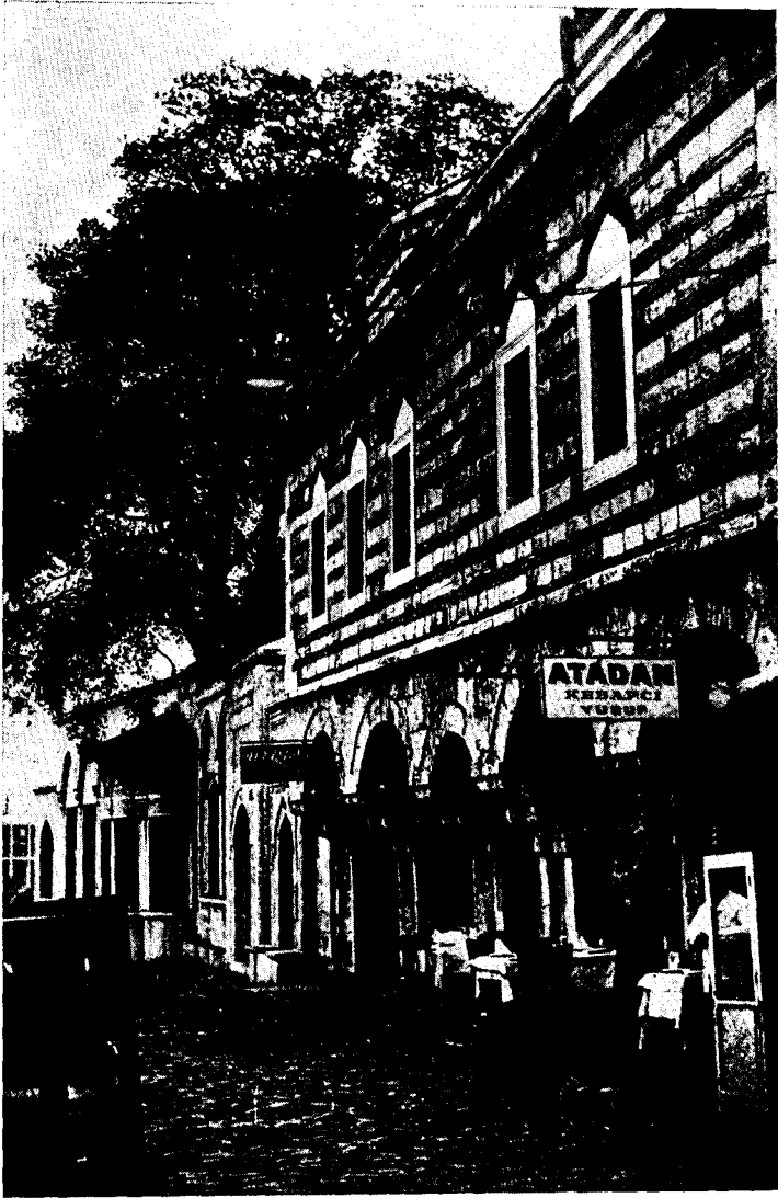
Res. 21 — Onarım sonunda Sibyan mektebi (Fot. Y. Önge)
