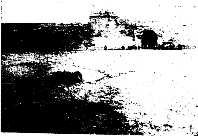
Düğer kervansarayından bir görünüş
