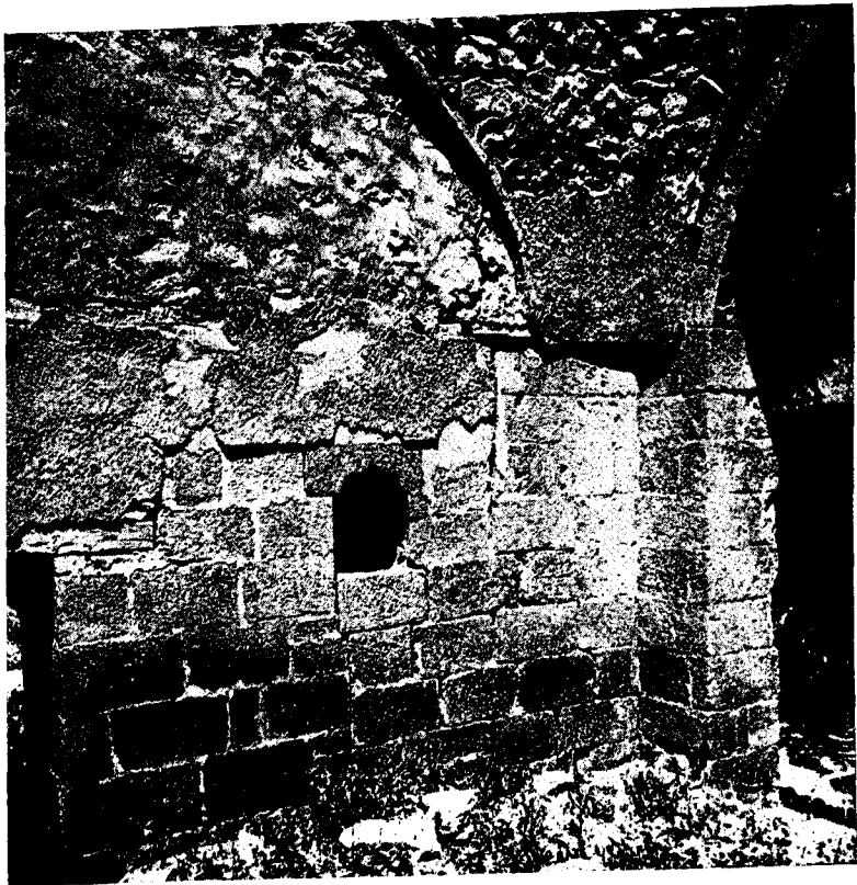
Res. 30 — 7 Nolu hacim - batı duvarı
