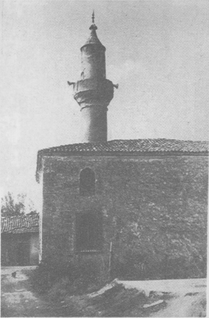
Res.: 9) İmaret Camiinin doğu kenarı. Burada doldurularak örülmüş bir pencere ile yan kanadın duvar üzerindeki izi görülmektedir.
