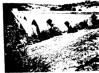
Taşlımüsellim tesisinde Yedigöz kemei(14).
