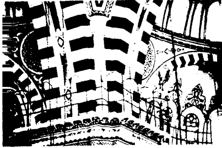
Resim 1-Fatih Camii Kubbe geçişi bölgesi
