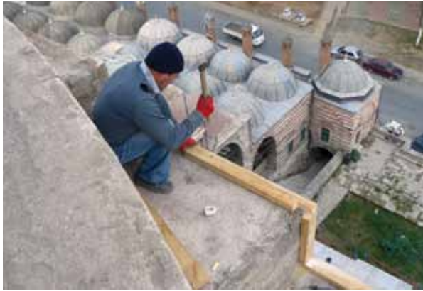
Fotoğraf 15 ve 16. Solda ahşap hatil çakılırken; sağda, taş yüzeyin temizlenmiş hali.
