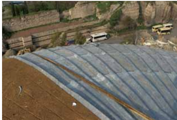
Fotoğraf 11 ve 12. Kubbedeki kurşun sökümü ve ortaya çıkan çimento sıvalar (solda).
