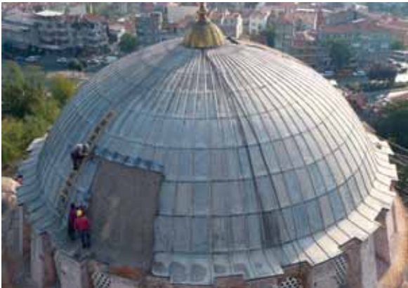
Fotoğraf 11 ve 12. Kubbedeki kurşun sökümü ve ortaya çıkan çimento sıvalar (solda).
