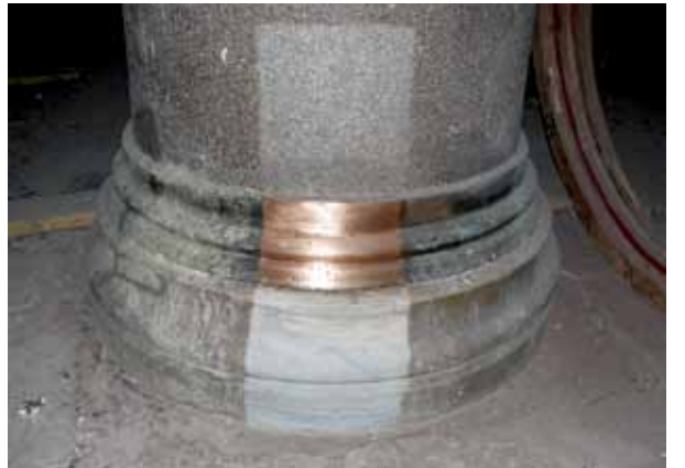
Fotoğraf 27. Sütun alt bileziğinin temizlenmesi.
