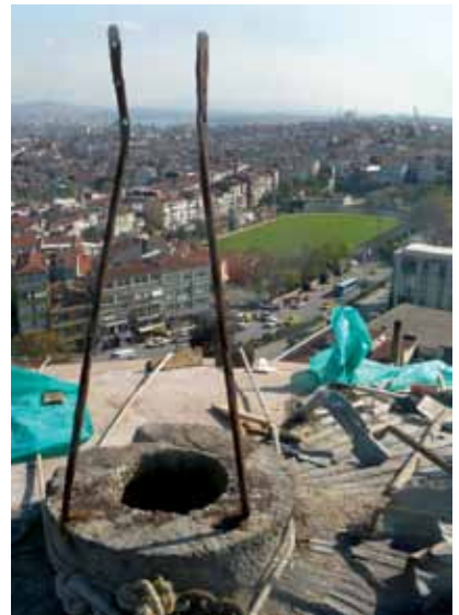
Fotoğraf 7 ve 8. Taş çürütme çalışması yapılırken ve imalat için taş çekilirken (Bekiroğlu İnş. Şantiyesi'nden).
