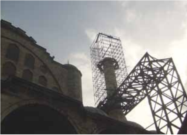
Fotoğraf 30 ve 31. Minarenin desteklenmiş ve tamamlanmış hâli (M.Sav, 2007-2008).
