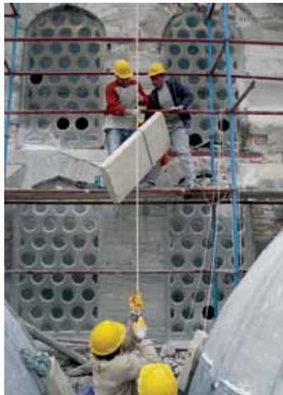
Fotoğraf 7 ve 8. Taş çürütme çalışması yapılırken ve imalat için taş çekilirken (Bekiroğlu İnş. Şantiyesi'nden).
