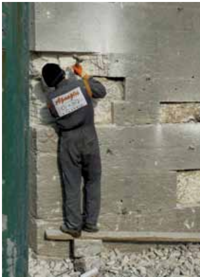
Fotoğraf 7 ve 8. Taş çürütme çalışması yapılırken ve imalat için taş çekilirken (Bekiroğlu İnş. Şantiyesi'nden).
