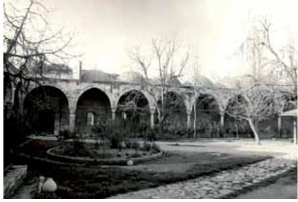
Fotoğraf 6. 1967 onarımı sırasında avlu ve medrese revaklarından görünüm (Vakıflar İst. 1.Böl.Müd. Arş.).
