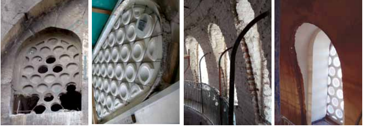
Fotoğraf 20 ve 21 . İmalat öncesi ve imalat sırasında pencere dışlığı.
