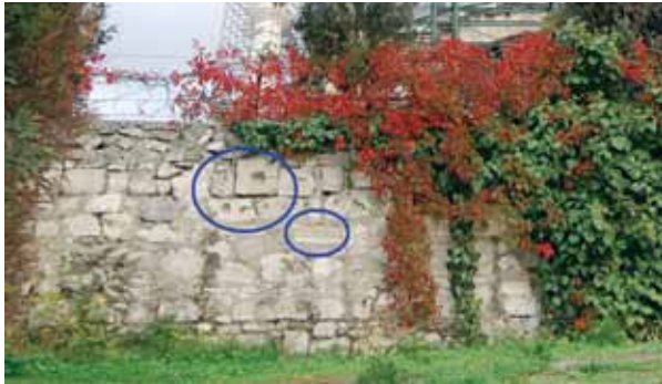
Fotoğraf 28- Caminin güney avlu duvarında kullanılan devşirme malzemeler (M.Sav, 2008).
