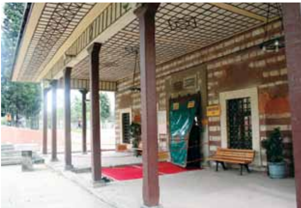
Fotoğraf 12. Restorasyon öncesi son cemaat yerinden görünüm.
