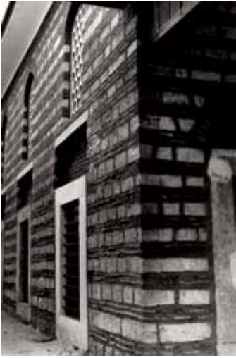
Fotoğraf 8. Şah Sultan Camii 1971 sonrası duvar örgüsü.
