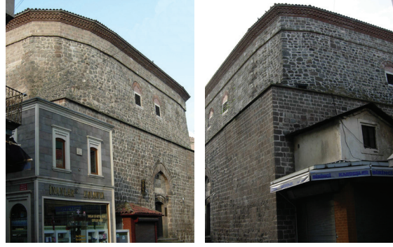
Resim 13. Restorasyon sonrası Kuzeydoğu cephesi (H. Emre Engin, 2010)
