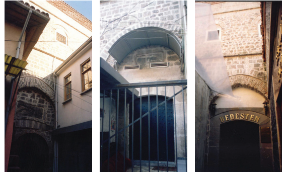
Resim 15. Restorasyon sonrası sırası ile Doğu, Batı ve Güney girişleri (H. Emre Engin, 2010)
