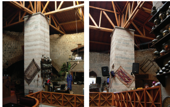
Resim 16. Restorasyon sonrası payelerin görünümü (H. Emre Engin, 2010)
