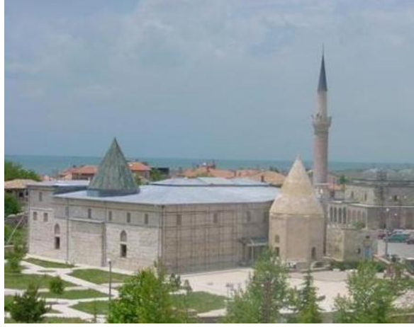
Resim 2.14 Eşrefoğlu Cami- Beyşehir (www.ilgazetesi.com.tr)
