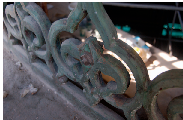
Fotoğraf 13. Kedi yolu korkulukları üzerindeki boya ve kalıntı halindeki altın kaplama tabakaları (örnek 2).
