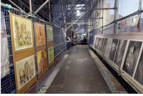
Fotoğraf 7. Cephe restorasyonu sırasında ziyaretçilere açık iskele ve bilgi panoları, San Petronio Katedrali, Bologna.
