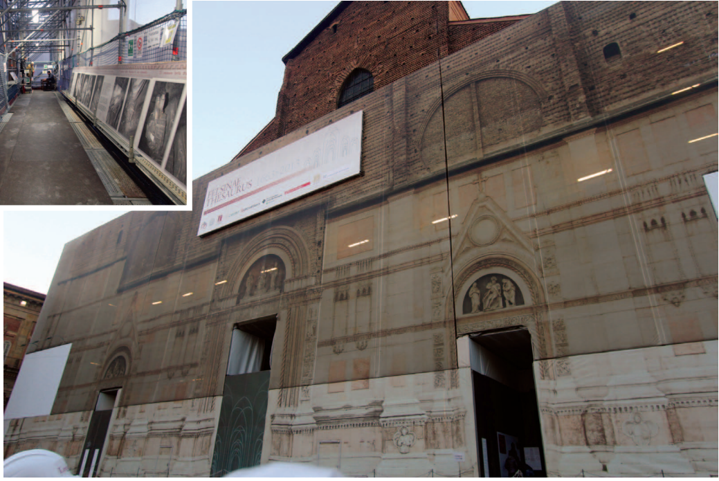
Fotoğraf 8. Cephe restorasyonu sırasında iskele brandası, San Petronio Katedrali, Bologna.
