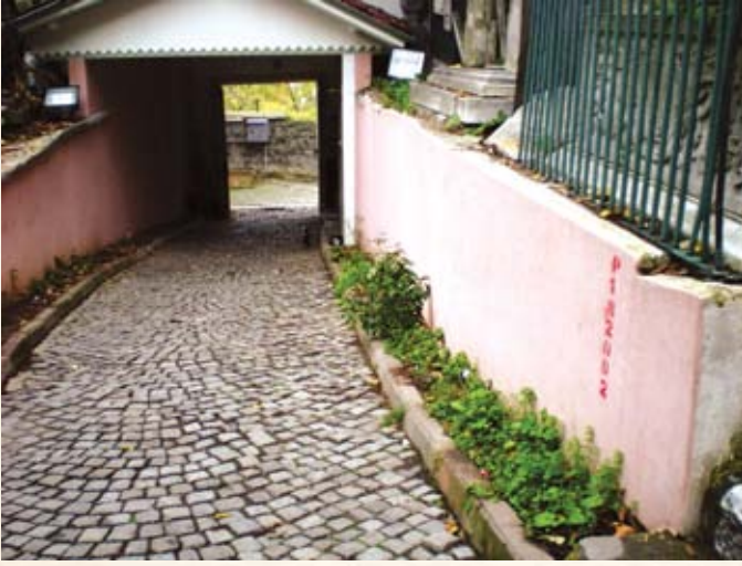
Resim, 1- 1 nolu yapı ve cümle kapısı ve üstü beşik çatı ile örtülü geçit
