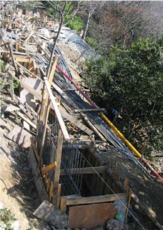
Resim, 28 - Yapımı devam eden istinat duvarları
