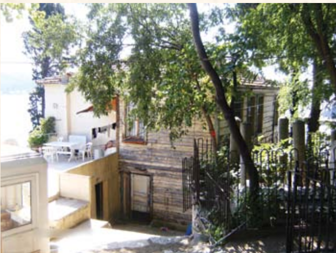
Resim, 5-5 nolu meşruta ve eski 6 nolu meşrutanın yerinde üstü teras olarak kullanılan altı ise wc olarak kullanılan yapı
