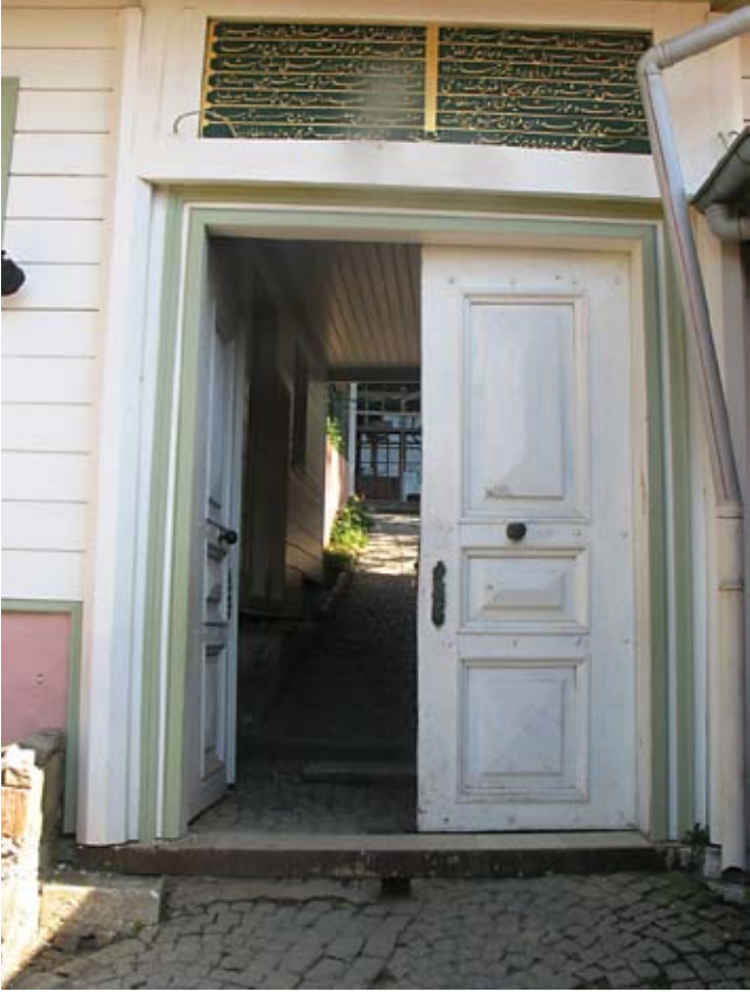
Resim 1- Tablalı ahşap kanatlı sade cümle kapısı ve Cümle kapısının eski fotoğrafı
