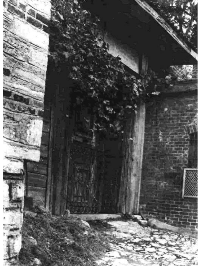
Resim 1- Tablalı ahşap kanatlı sade cümle kapısı ve Cümle kapısının eski fotoğrafı
