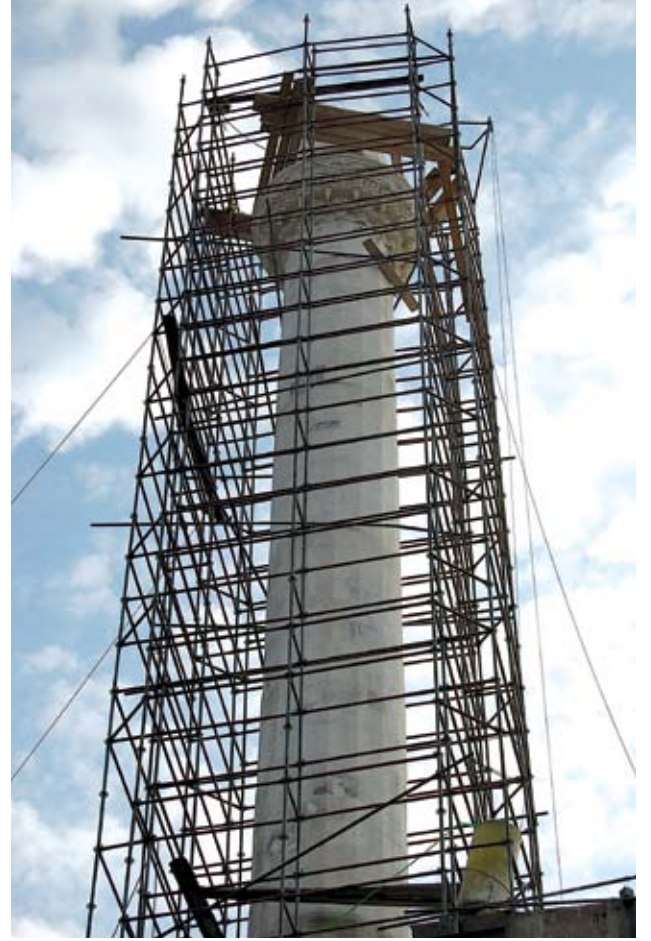
Resim,14-Uygulama esnasında minare
