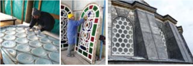
Resim,18- Pencere dışlık ve içliklerinin tamiri ve yerine takılması
