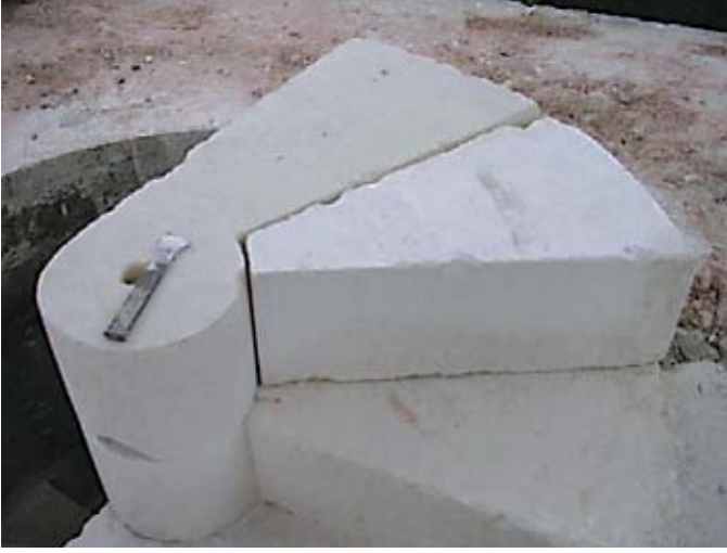
Resim,5- Edirnekapı Mihrimah Sultan Camiinden yedek basamak imalatı ve gömleklı kaide kaide planı
