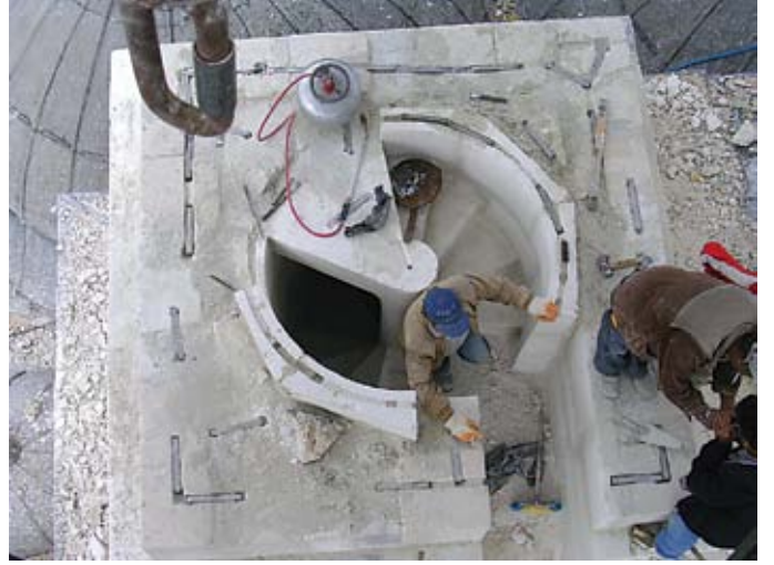
Resim,5- Edirnekapı Mihrimah Sultan Camiinden yedek basamak imalatı ve gömleklı kaide kaide planı
