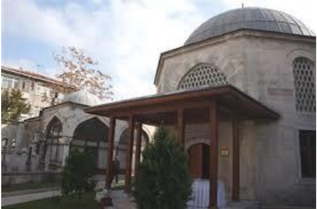
Restorasyon Sonrası Külliyeden Görünüm
