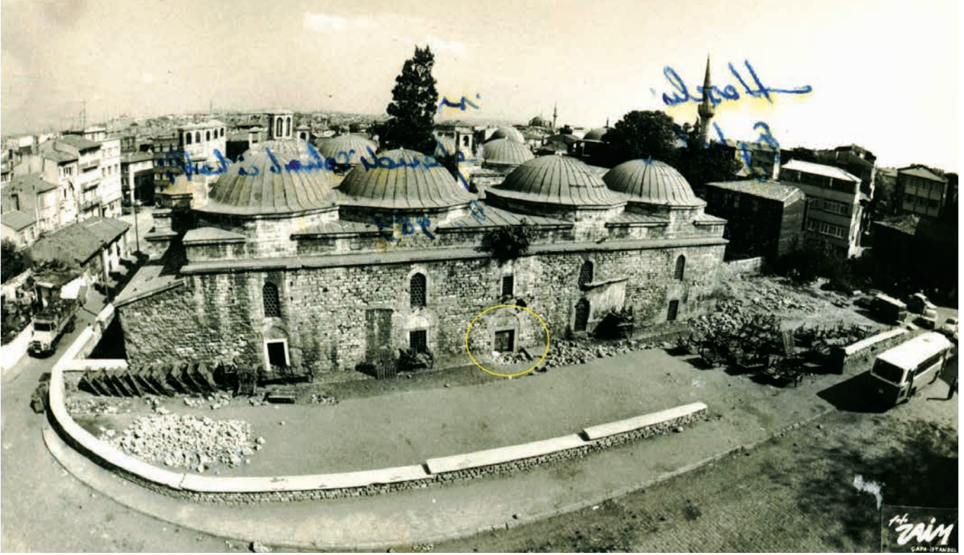
Fotoğraf 23. Haseki İmaret, 1984 restorasyonu öncesi (Vakıflar Arşivi)
