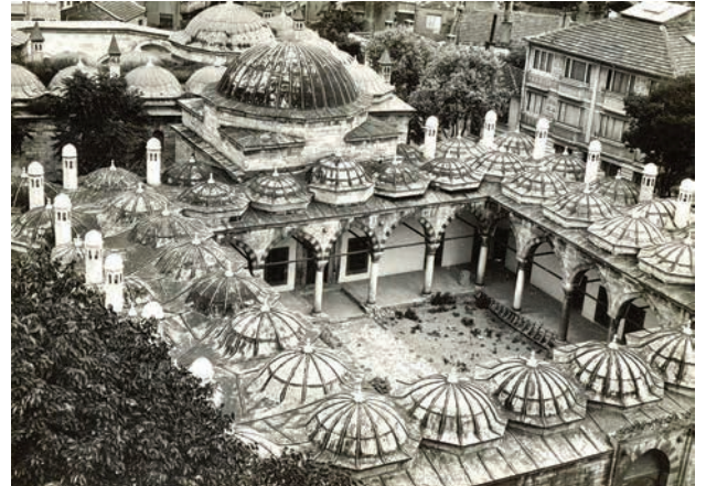
Fotoğraf 8. Haseki Medresesi (Vakıflar Arşivi, 1964 onarım dosyası)
