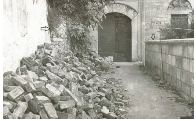
Fotoğraf 16. İmaret aralığı (Vakıflar Arşivi, 1968 onarım dosyası)
