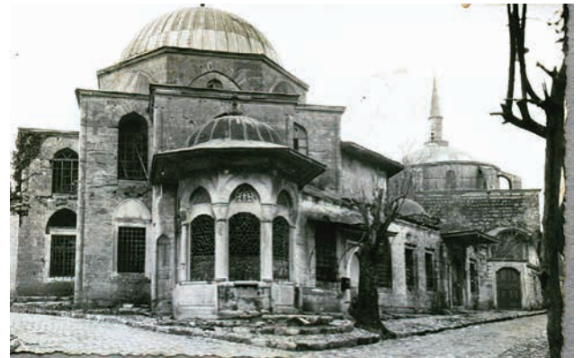
Fotoğraf 4. Bayrampaşa Külliyesi (Encümen Arşivi, 1936)
