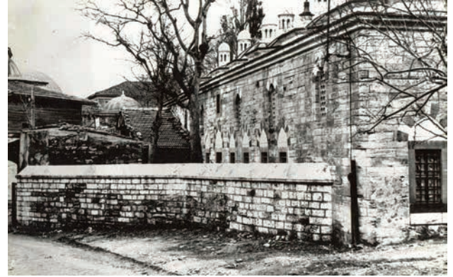
Fotoğraf 11. Medresenin Sami Paşa Sokağı cephesi, restorasyon sonrası (Vakıflar Arşivi, 1960 onarım dosyası)
