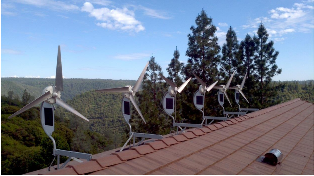
Resim 3.4: Bina-monte rüzgar türbini örneği (Url-12).
