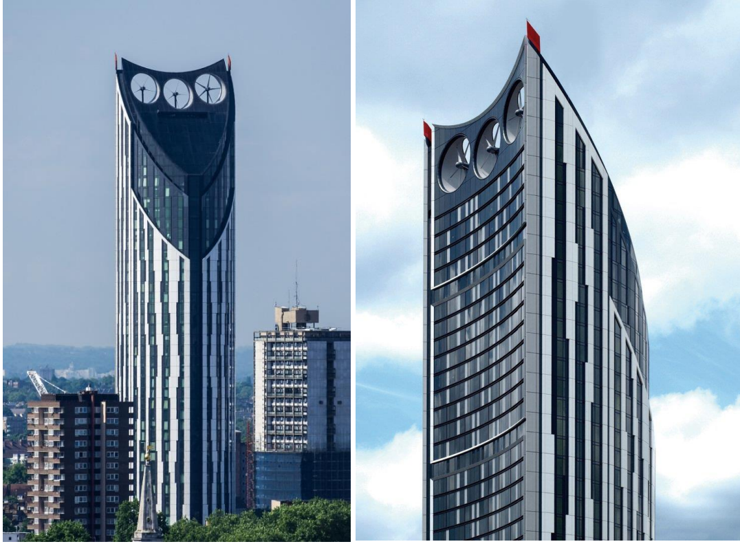
Resim 4.9: Strata Kulesi genel görünümü (Url-25).
