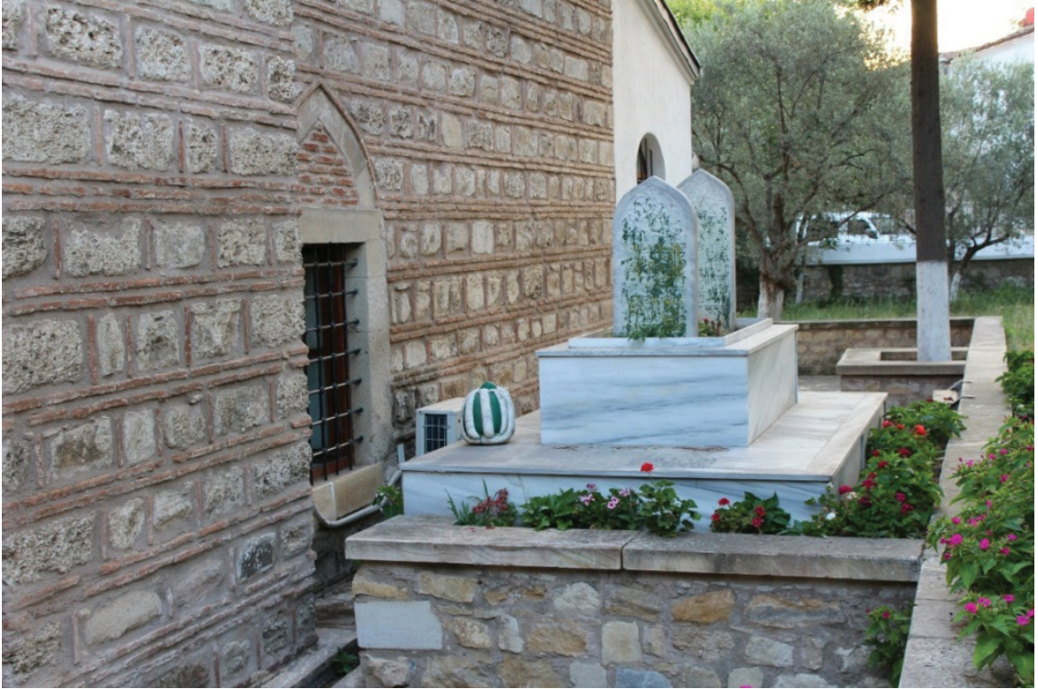
Resim 5. Çardak, Yakup Bey Câmii Güney Cephesi ve Yakup Bey Kabri
