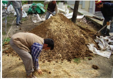
40. Kurşun örtününün altına serilecek çamurun hazırlanması
