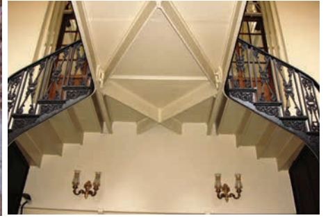
60.Onarım sonrası merdiven sahanlığı
