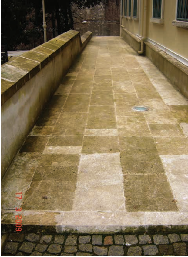
80. Onarım sonrası arka cephe
