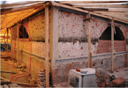
36.Kubbe kasnağına çelik takviyenin yapılması, kubbe ve kubbe kasnağının güçlendirilmesi
