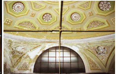
27. Onarım Öncesi Kubbe Kasağı
