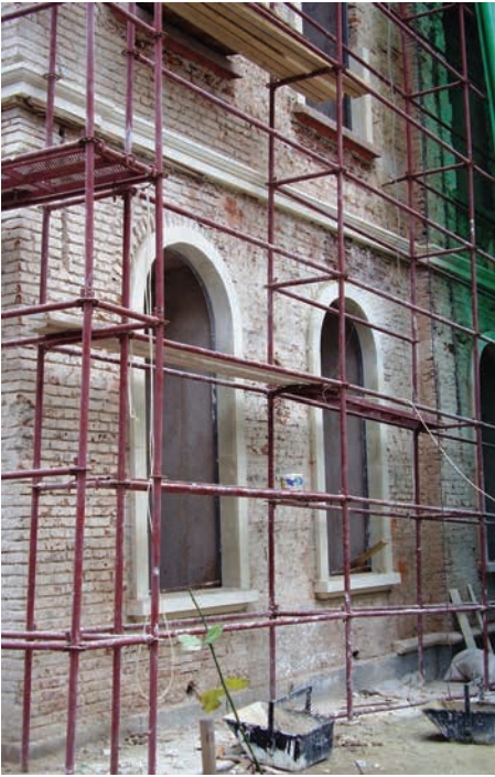
35.Özgün olmayan sıvanın dış cepheden raspa edilmesi
