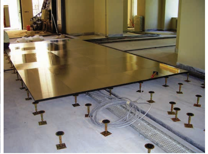
69.Tesisat kanallarını gizlemek için yükseltilmiş döşeme uygulaması
