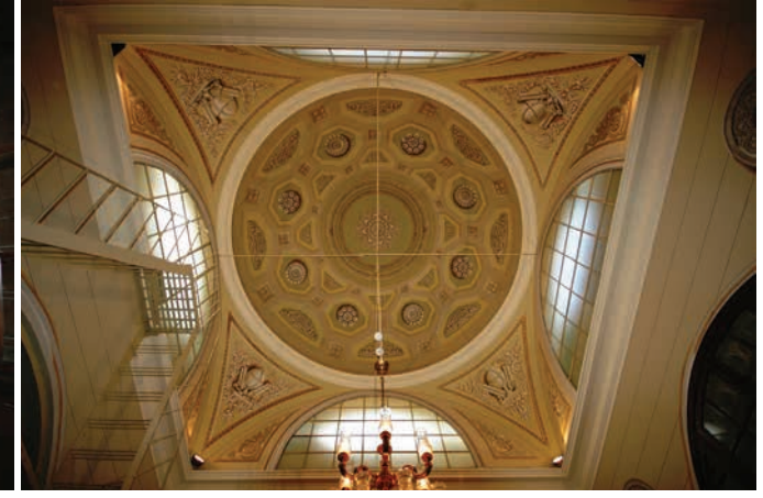
73. Onarım sonrası kubbe
