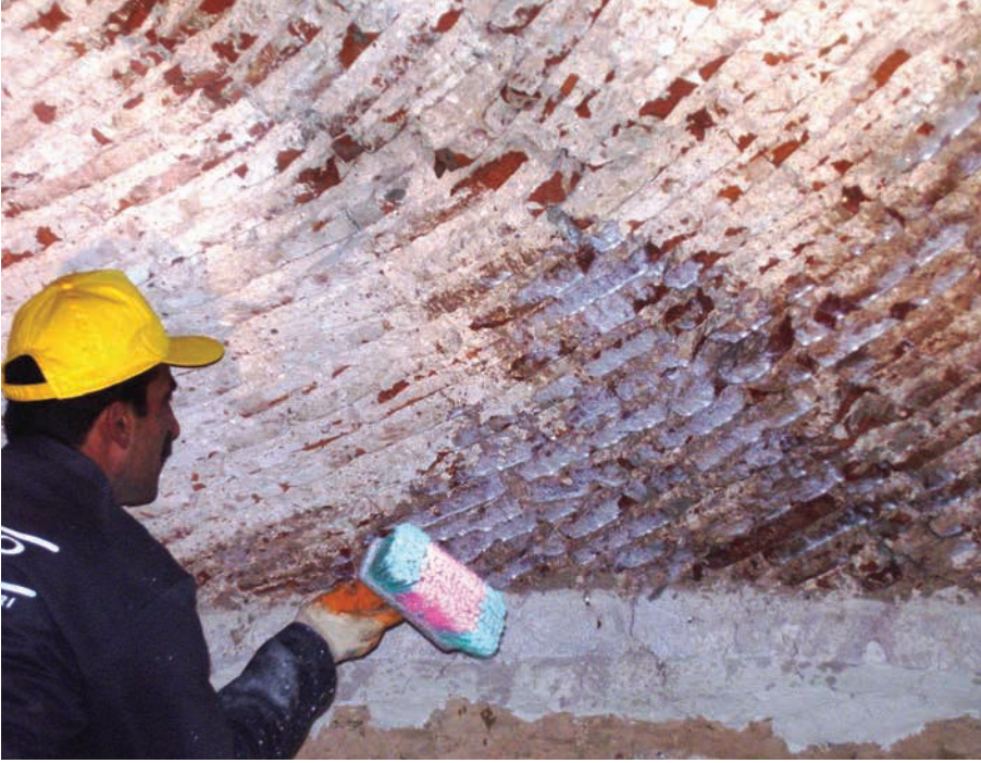
51.Yapısal çatlakların karbon fiber ile onarılması
