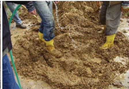
41. Kurşun örtününün altına serilecek çamurun hazırlanması
