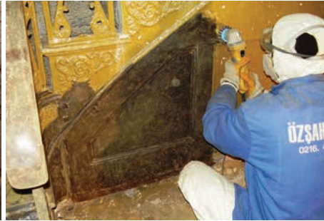
56.Merdiven ve korkuluklarının özgün olmayan boyalarının mekanik yöntemlerle temizlenmesi
