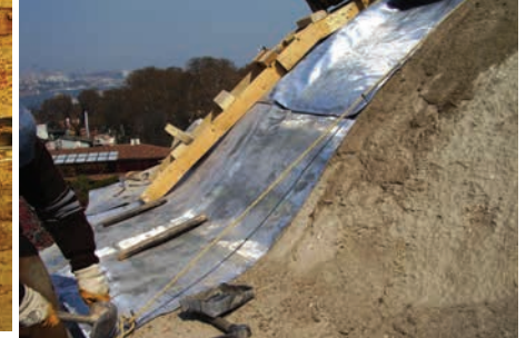
43.Kurşun örtününün kaplanması
