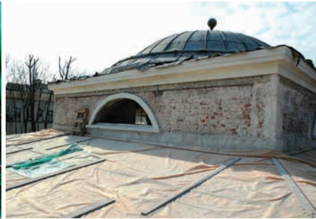
39. Kasnak silmesinin ve kasnak pencere sövesinin yapılması
