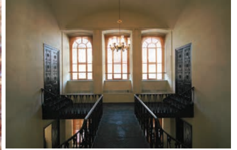
59.Onarım sonrası giriş merdiven sahanlığı ve korkuluklar
