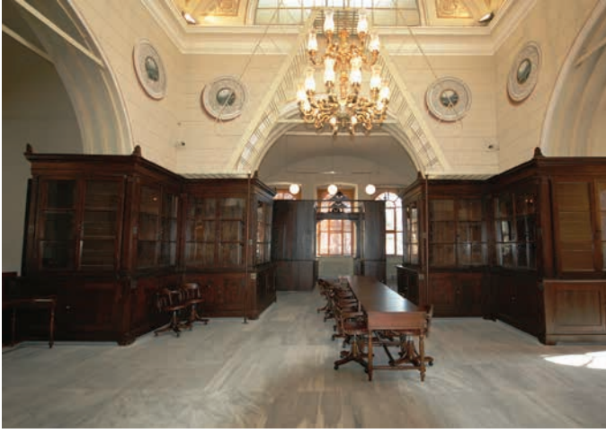
70. Onarım sonrası üst kat
