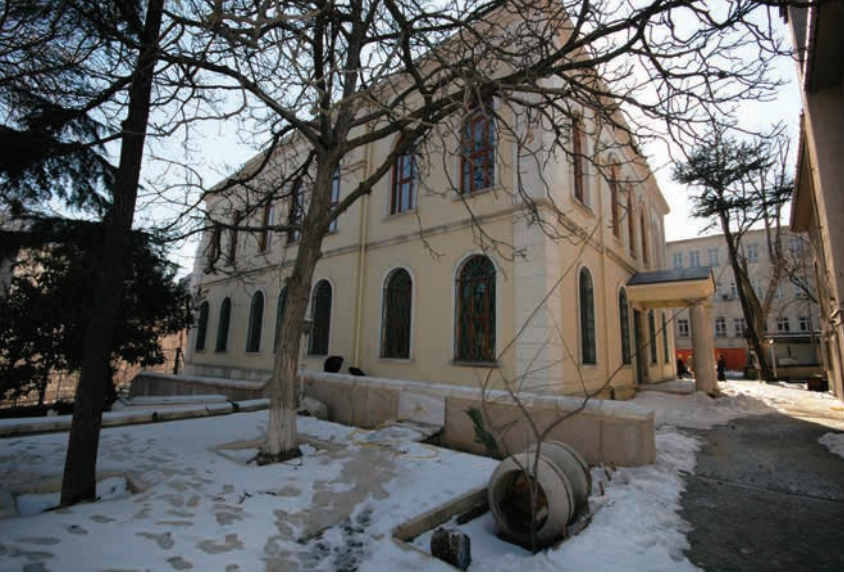
82. Onarım sonrası yan cephe
