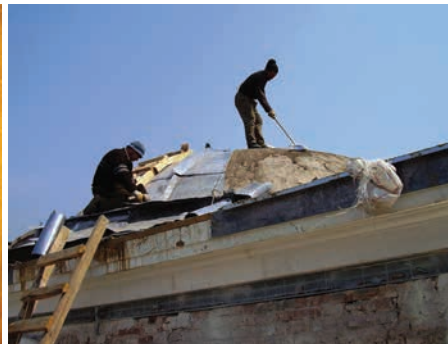
42. Kurşun örtününün kaplanması
