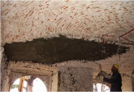
52.Yapısal çatlakların karbon fiber ile onarılması
