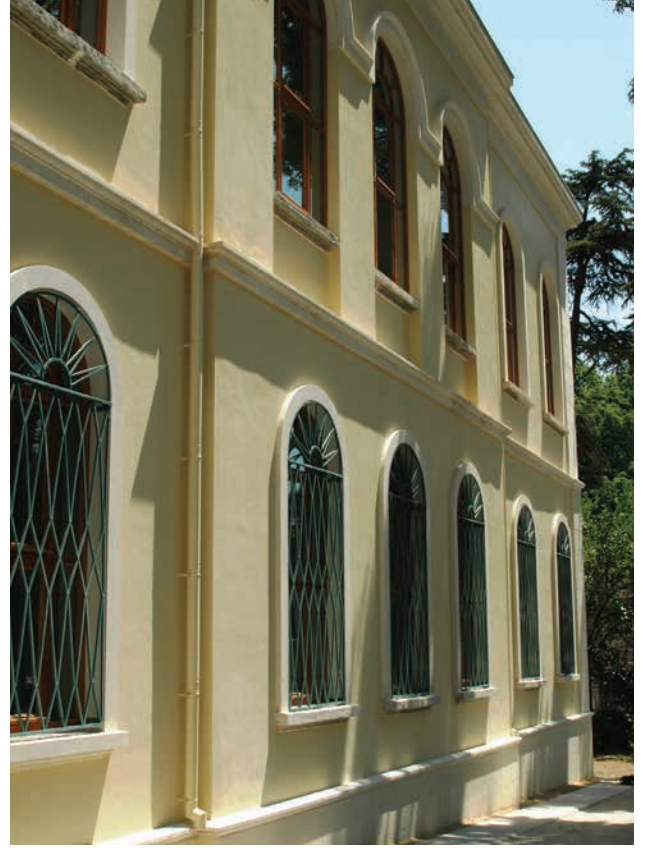
81. Onarım sonrası yan cephe
