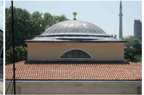
44.Onarım sonrası kubbe ve çatı yapılıması
