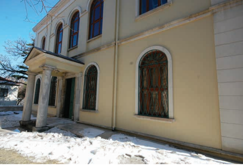
83. Onarım sonrası giriş cephesi
