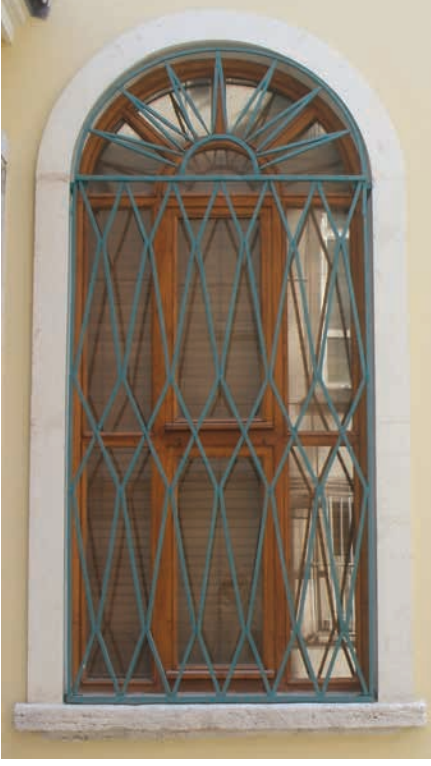
62. Onarım sonrası demir parmaklık ve ahşap doğrama
