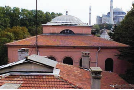
18. Onarım Öncesi Çatı Görünüşü
