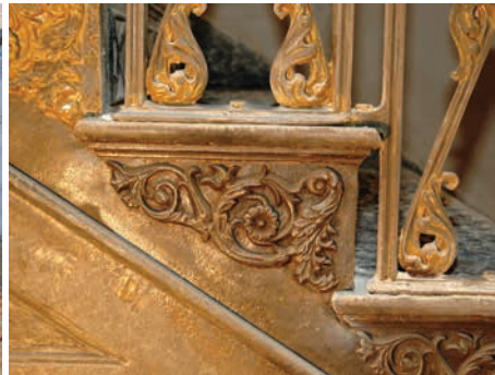
57.Merdiven ve korkuluklarının temizlenmiş hali
