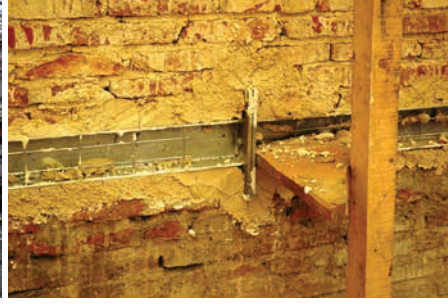
38. Kubbe kasnağının çelik putrellerle güçlendirilmesi / ayrntı
