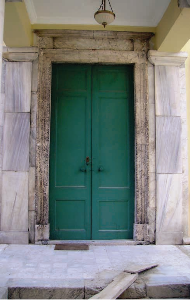
47. Onarım sonrası giriş kapısı
