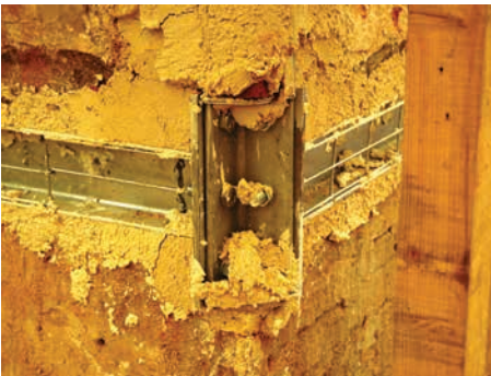
37. Kubbe kasnağının çelik putrellerle güçlendirilmesi / ayrntı
