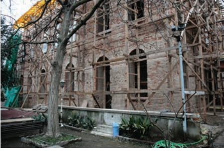
34.Özgün olmayan sıvanın dış cepheden raspa edilmesi
