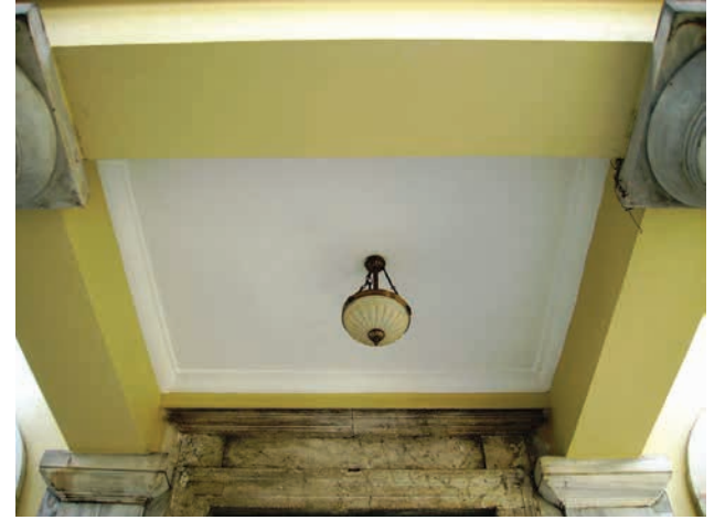
49. Onarım sonrası / restorasyon
