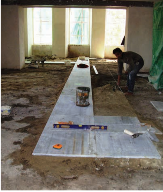
66.Özgün ebatlı mermer döşemelerin yapılması
