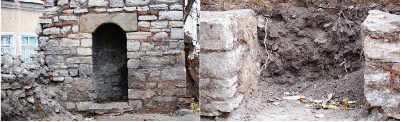
Fotoğraf 9. Kazı sonrası minare girişi ve yanda kapı açıklığı
