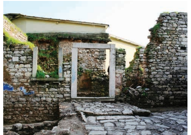
Fotoğraf 34 .Çalışma sonrası düz lentolu kapı ve döşeme taşları (Z.Burnu Belediyesinden)
