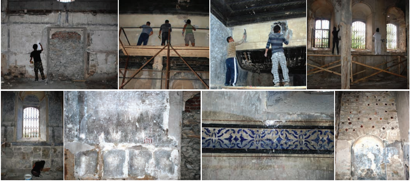
Fotoğraf 26-33. Kilisede yapılan raspa çalışmaları
