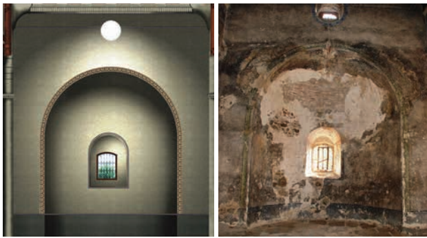
Fotoğraf 56-57. Apsis duvarı restitüsyonu
