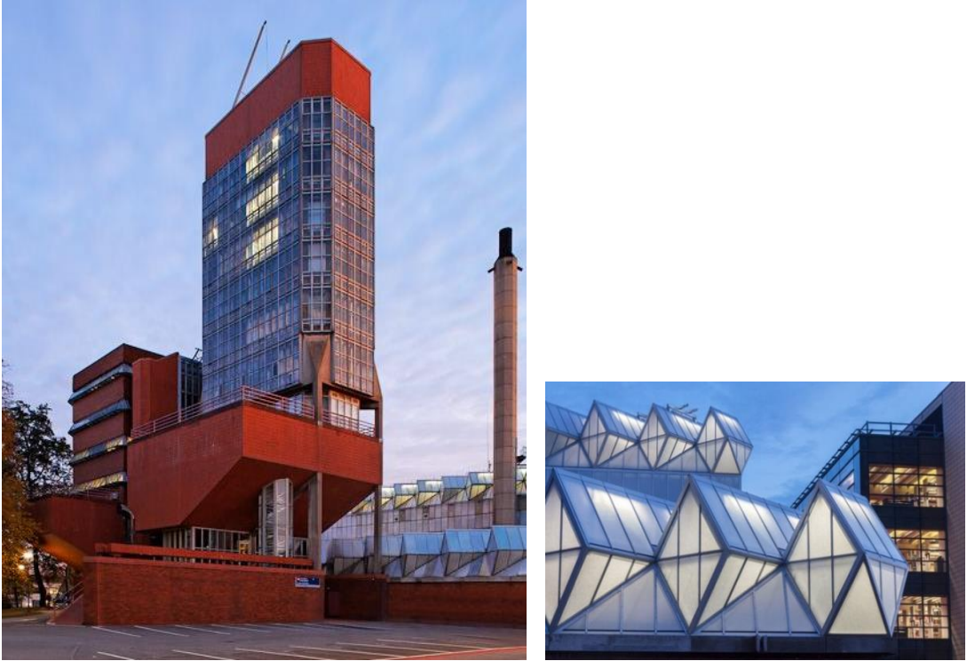
Resim 3.1: Leicester Üniversitesi Mühendislik Binası, Görünüş, İngiltere, 1963 (URL-16).
