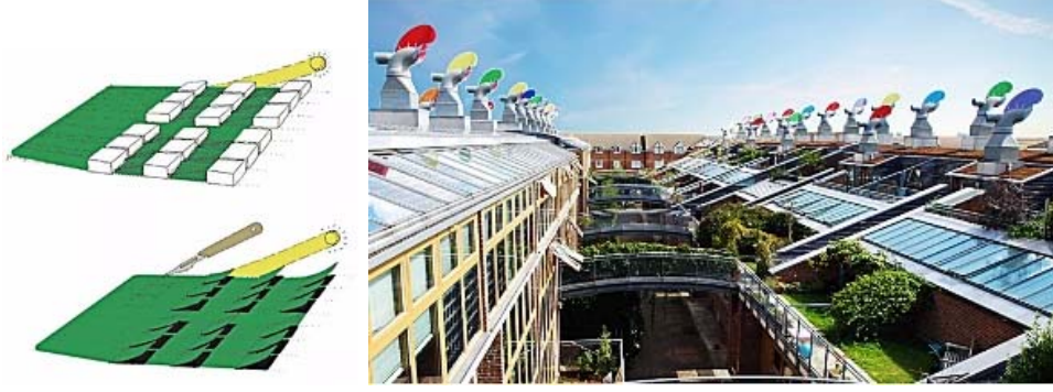
Resim 4.10 Rüzgar ile ısı geri kazanımlı havalandırma yapan rüzgar bacaları ve güneş pilleri (Url- 30)
