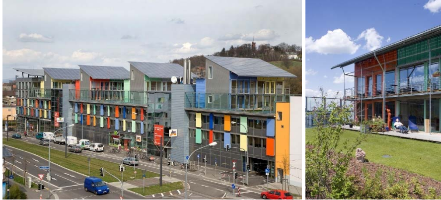
Resim 4.16 Yapı çatısı ve pasif ısıtma sistemi (Url- 35)
