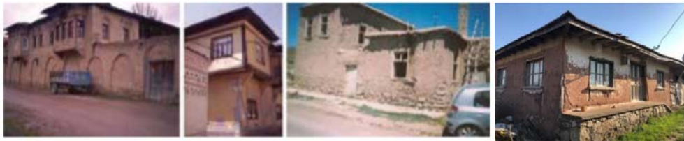
Resim 1.4 Konut mimarisinde kerpiç malzemesinin kullanımı (Uşma, 2018; Sarıkaya, Arpacıoğlu, 2019)
