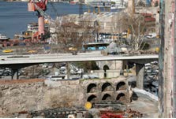
Fotoğraf 30. Çeşmenin yakınında inşa edilen Haliç Metro Geçiş Köprüsü (2013)
