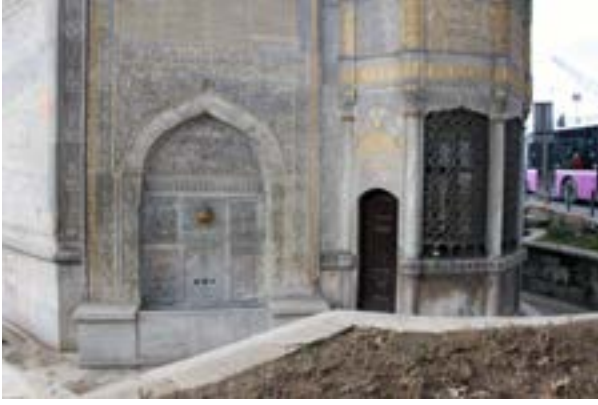
Fotoğraf 3. Asimetrik kütle biçimlenişi, parapet duvarı ve özgün zemin kotu (2013).
