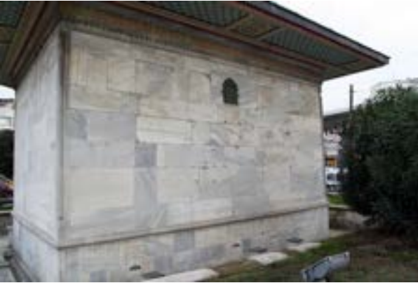
Fotoğraf 15. Güneybatı cephesi (2013)
