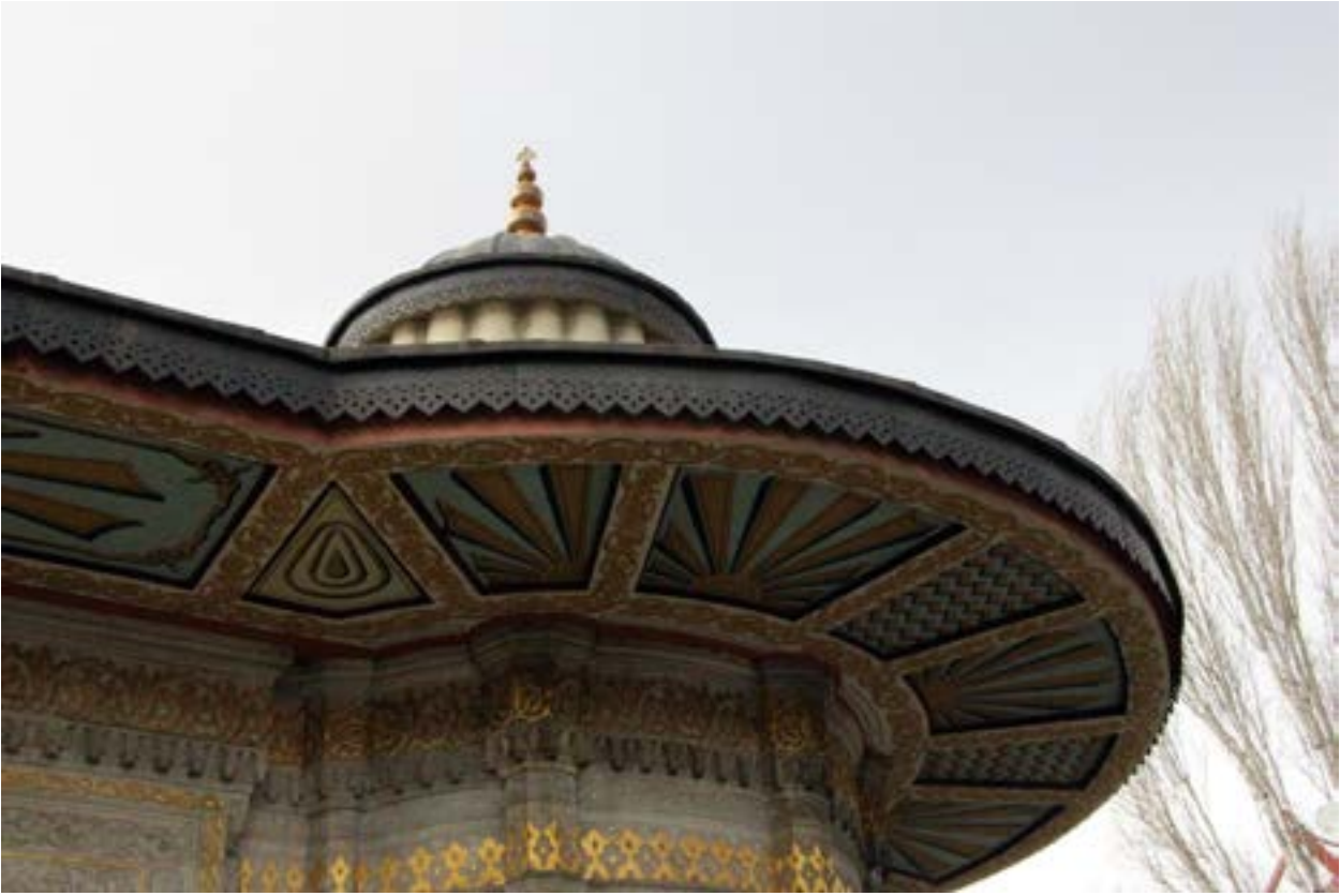
Fotoğraf 7. Metal festonlar, şacak altındaki kalemişi bezeme ve mukarnash şacak silmesi (2013)
