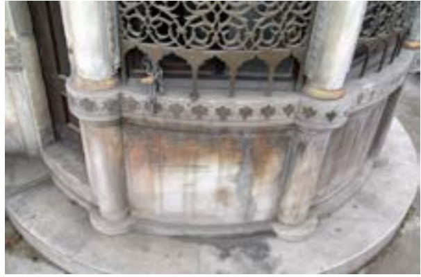
Fotoğraf 14. Şebeke parapeti altındaki kararma ve renk değişimi (2013)
