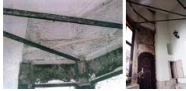
Fotoğraf 26-27. Sebil tavanındaki gergi demirleri Restorasyon öncesi (2001) ve sonrası (2013)
