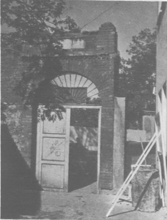
Resim 4: Tekkenin yan tarafındaki üzerinde besmele yazılı kitabe bulunan kapının görünüşü.
