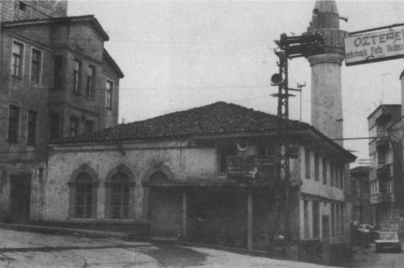
Resim 10: Gözaçan Camii'nin yıkılmadan önceki hali.
