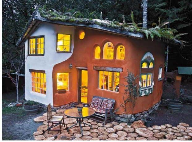
Resim 2. 27: Dökme toprak tekniğiyle inşa edilmiş bir yapı (URL 38).
