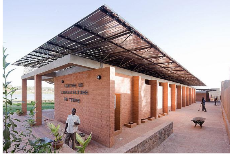
Resim 2. 23: Sıkıştırılmış toprak bloklar tekniğiyle inşa edilmiş kamu yapısı(Mali) (URL 33).
