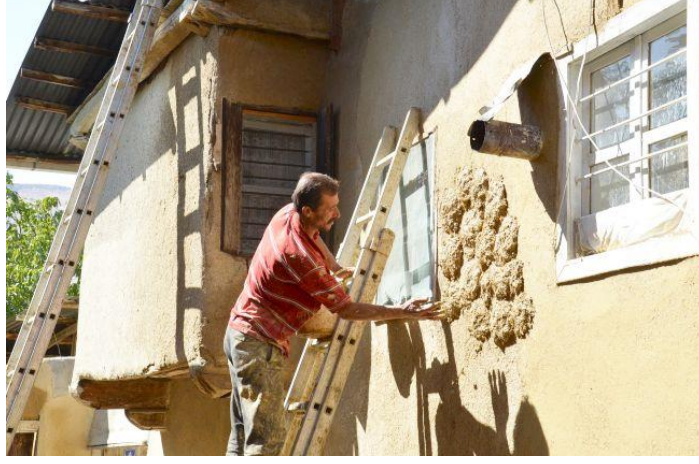
Resim 2. 35: Kerpiç yapıda duvara sıva çekme işlemi (URL 45).
