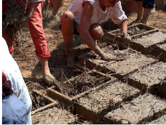
Resim 2. 32: Samanın kerpiç harcında kullanılması (URL 42).
