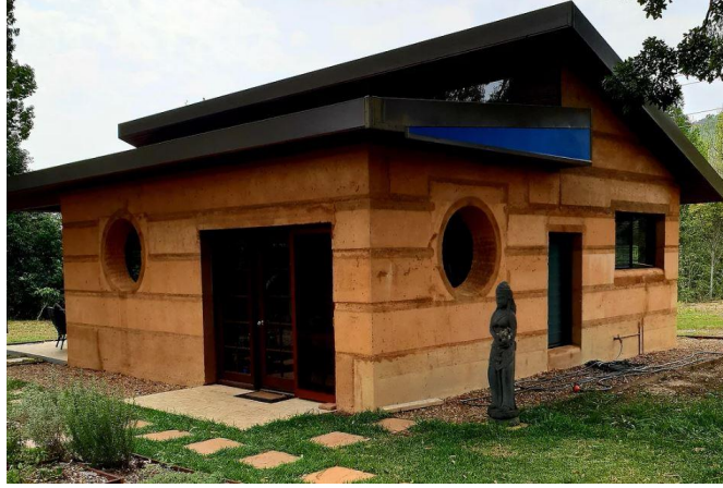
Resim 2. 29: Dökme toprak tekniđi ile inşa edilmiş bir ev (URL 39).
