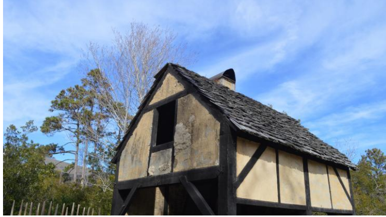
Resim 2. 20: Omurgalı kerpiç tekniğiyle yapılmış bir yapı (URL 29).
