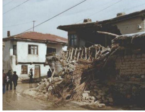
Resim 4. 4: Strüktür sorunu olan kerpiç duvarın deprem sonrası görünüşü (Koçu ve Korkmaz, 2004).
