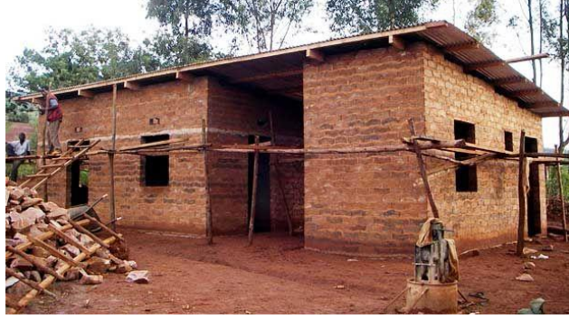
Resim 2. 22: Sıkıştırılmış toprak bloklar tekniğiyle inşa edilmiş bir yapı (URL 32).
