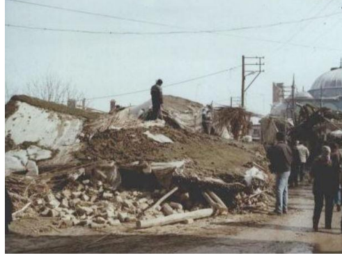
Resim 4. 3: Konya'da kerpiç malzemeli, ağır toprak damlı yapının yıkıntısı (Koçu ve Korkmaz, 2004).
