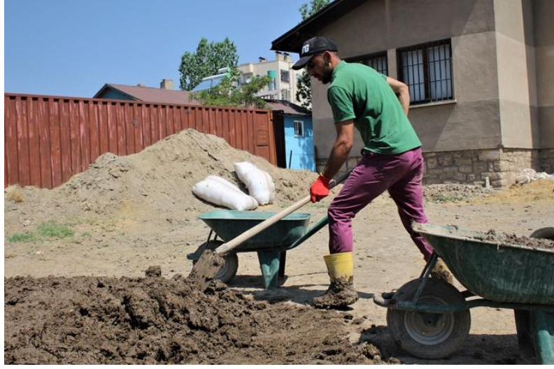
Resim 2. 1: Kerpiç harcının kol kuvvetiyle karıştırılması (URL 15).
