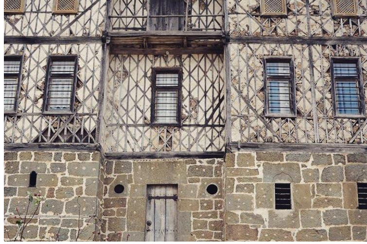
Resim 2. 18: Kerpiç dolgulu hımış yapı örneği (URL 27).
