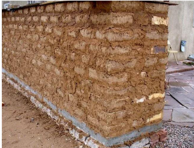
Resim 2. 34: Kerpiç bloklarla oluşturulmuş duvar (URL 44).
