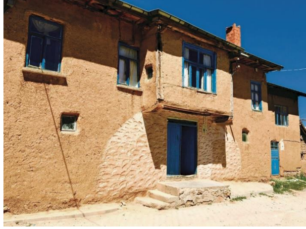
Resim 2. 16: Bezeli yığma kerpiç yapı (URL 25).
