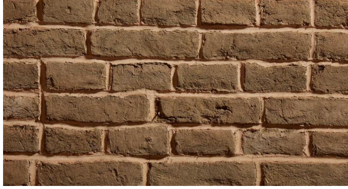
Resim 2. 33: Kerpiç tuğlaların oluşturduğu bir duvar görüntüsü (URL 43).
