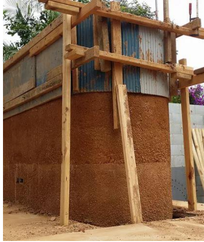
Resim 2. 28: Dökme toprak tekniği yapılış aşaması (URL 39).
