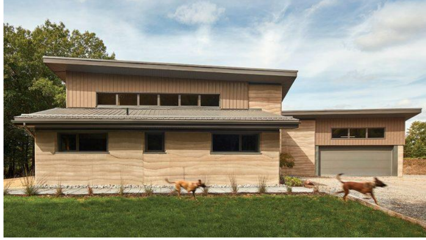
Resim 2. 25: Dövmе duvar tekniđiyle yapılmıř bir yapı (URL 36).
