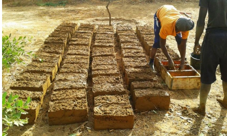
Resim 2. 2: Kerpicin kalıplara dökülüp sıkıştırılması (URL 16).
