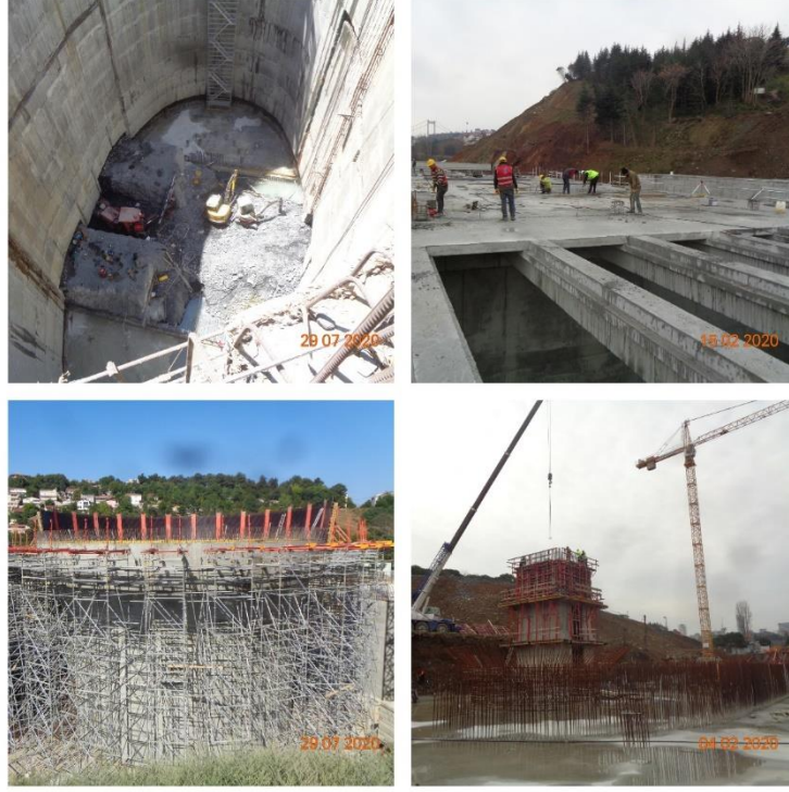
Resim 3.4: Terfi, Havalandırma Havuzları, Çürütücü ve Asansör Kulesi İmalatları
