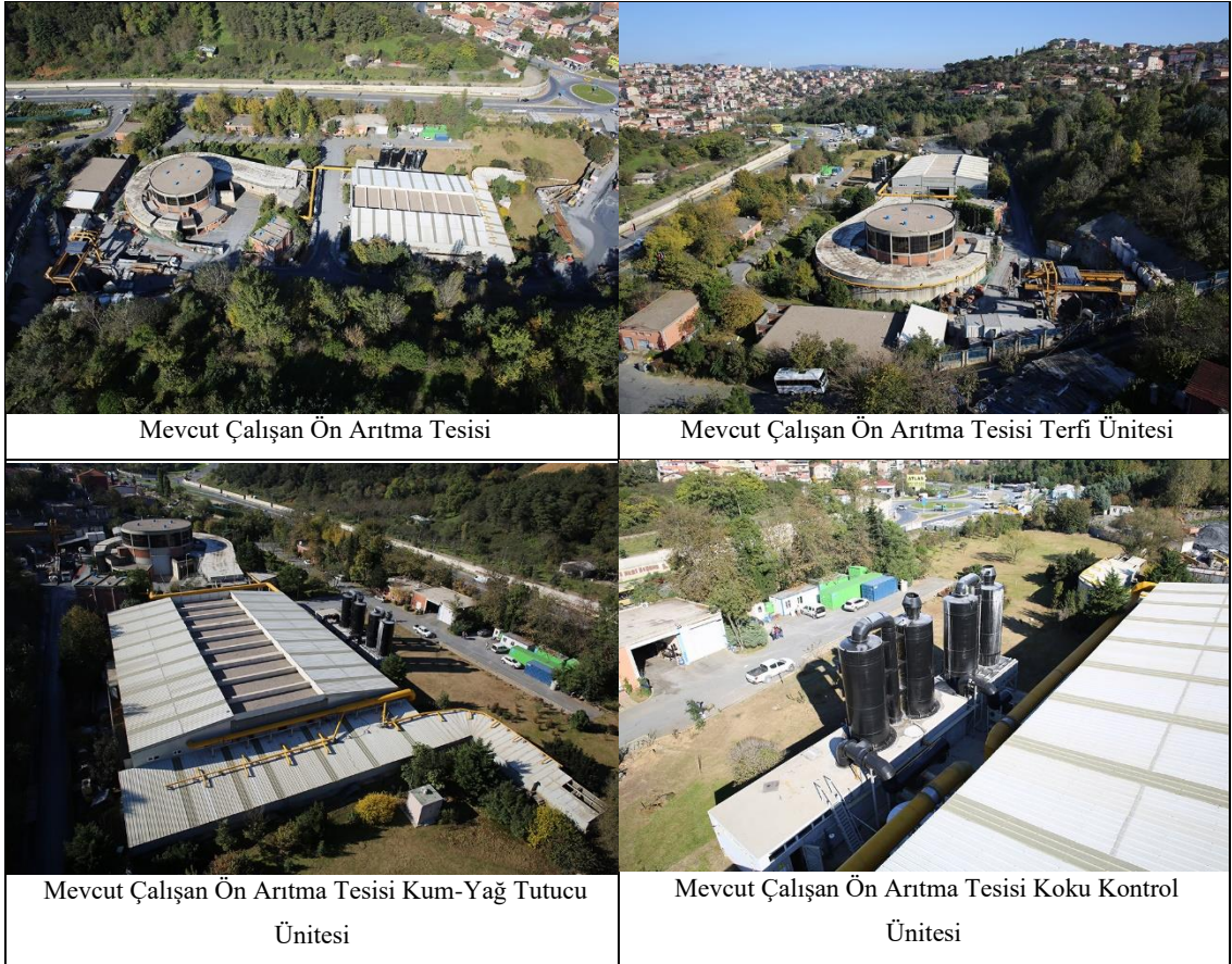
Resim 3.1: Mevcut Çalışan Ön Arıtma Tesisi ve Üniteleri
