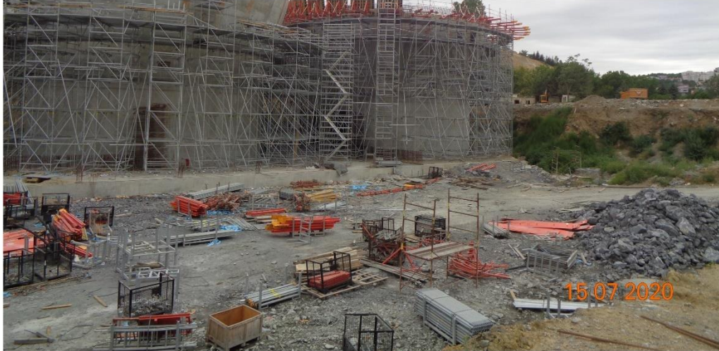
Resim 3.6: Şantiye Alanına Malzemelerin İstiflenmesi
