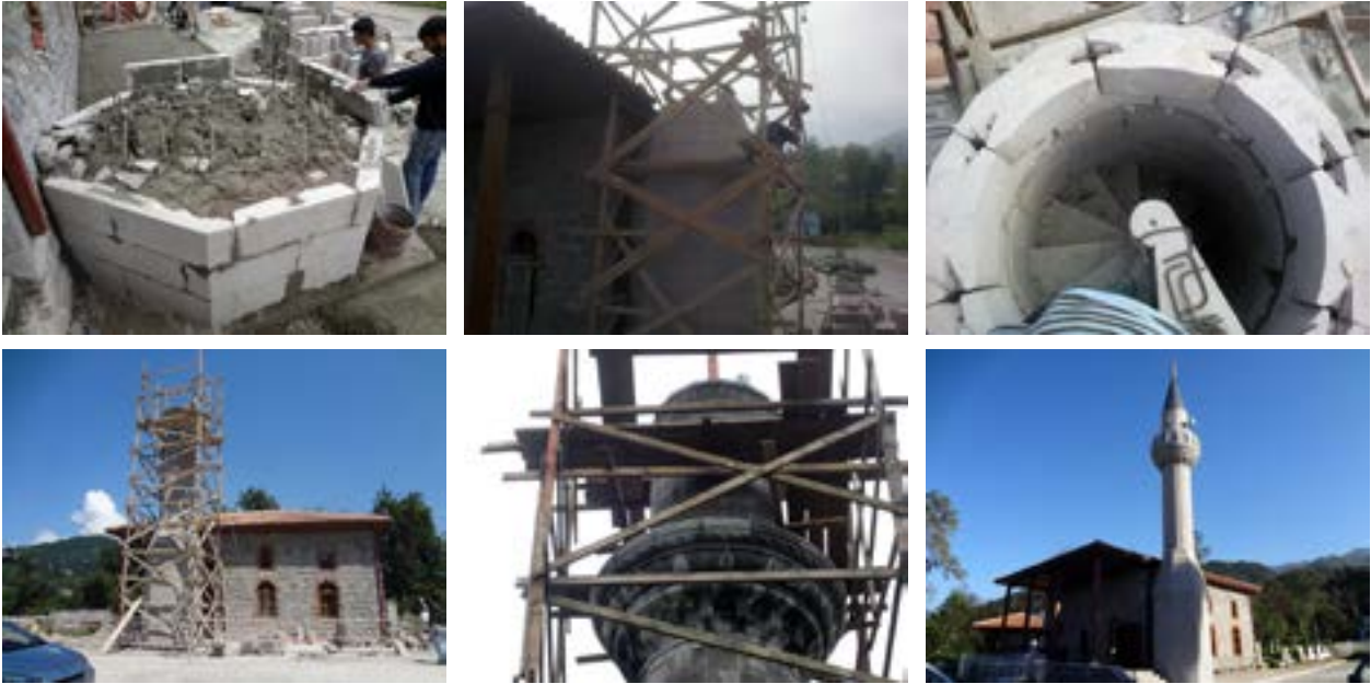
Fotoğraf 5. Sundura Camisinin minaresinin yapımına ait görüntüler.
