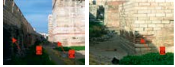
Şekil 2. Belgrad kapıda C3 ve C4 numaralı harç örneklerinin alındığı yerler
