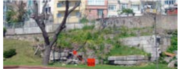
Şekil 6. Çatladı kapı D28 (derz) ve D29 (dolgu) harç örneklerinin alındığı yerler
