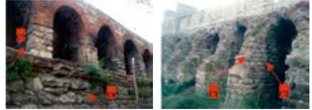
Şekil 3. (a).Silivri Kapı (Pege) C6 ve C7 (b).Mevlana Kapı C1 ve C2 numaralı harç örneklerinin alındığı yerler
