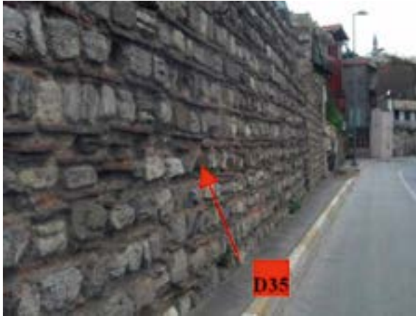
Şekil 12. (a). Petri Kapı civarı D35 ve (b).D36 numaralı harç örneklerinin alındığı yerler
