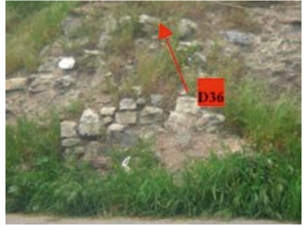
Şekil 12. (a). Petri Kapı civarı D35 ve (b).D36 numaralı harç örneklerinin alındığı yerler
