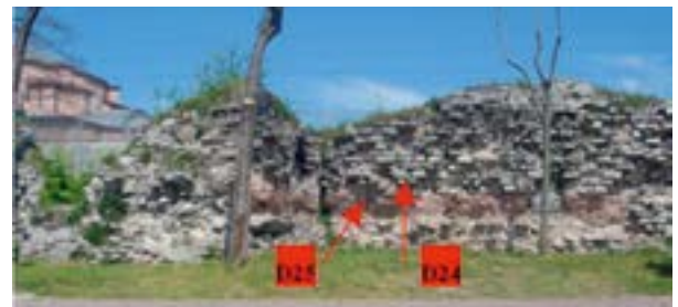
Şekil 7. Marmara Surları 37. kule civarı D24 (derz harcı) ve D25 (dolgu harcı) numaralı örneklerin alındığı yerler
