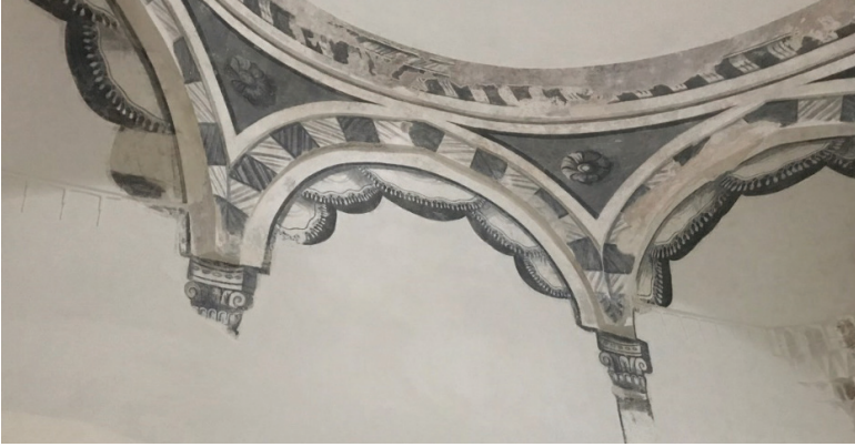
Resim 11. Zeyrek Çinili Hamam, kadınlar bölümü soyunmalık mekânı kalem işleri (Ekim 2020)
